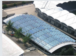
Fernwärmeinspeisung Liebenauer Stadion, Graz
