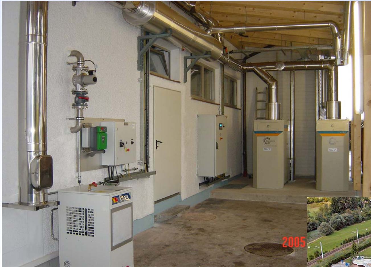
Kläranlage RHV-Hallstättersee 2 x C 30 Biogas
