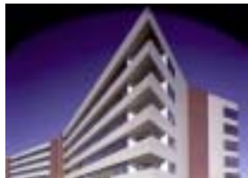
Endverbrauchttechnologien in Industrie und Gebäude, CHP
