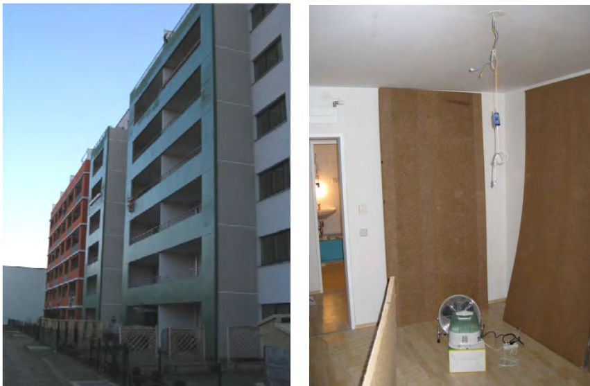
Abbildung 62: Wohnhaus in dem eine Wohnung für Versuchszwecke bereitgestellt wurde (links) und Erhöhung der Feuchtepufferwirkung eines Raumes durch ca. 50m 2 2cm dicke Weichfaserplatten (rechts)
