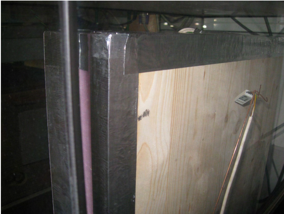
Abbildung 37: Erster Schimmelbefall bei der Schichtholzplatte nach 63 Tagen
