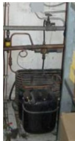
Abbildung 2.21a und b: Einzelanlage – Einem Kühlraum ist ein (luftgekühlter) Verflüssigungssatz zugeordnet.
