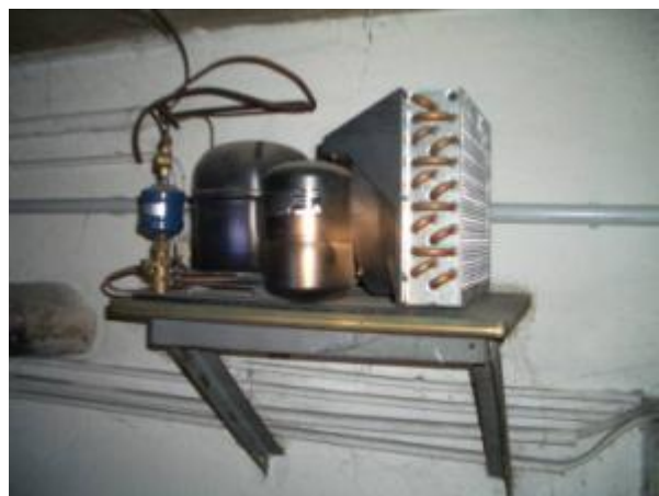
Abbildung 2.21a und b: Einzelanlage – Einem Kühlraum ist ein (luftgekühlter) Verflüssigungssatz zugeordnet.
