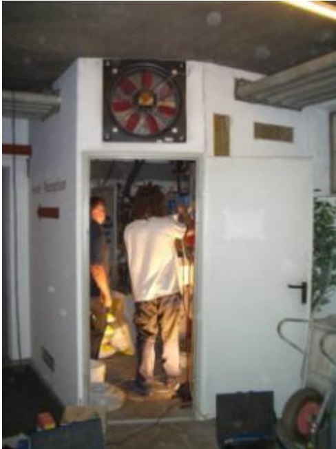
Abbildung 4.2: Tiefgarage Kälteanlagenraum mit Ventilator zur Entlüftung des Raumes
