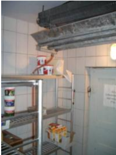
Abbildung 4.7: Verdampfer Fleisch-Vorkühlraum
