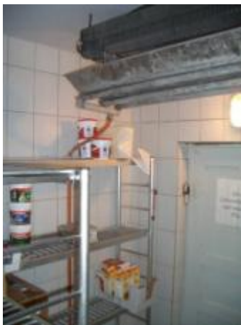
Abbildung 2.21a und b: Einzelanlage – Einem Kühlraum ist ein (luftgekühlter) Verflüssigungssatz zugeordnet.
