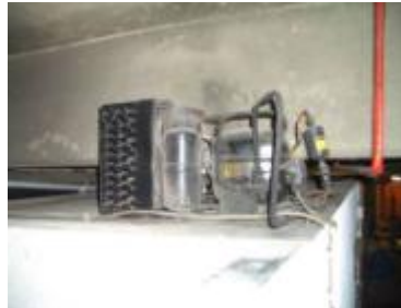
Abbildung 4.4 a- c: Verflüssigungssätze außerhalb des Technikraumes
