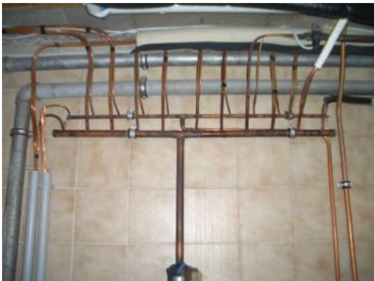
Abbildung 4.13 a bis d: Verbundanlage mit Kompressor, Wärmerückgewinnung, Verteilung, Schaltschrank
