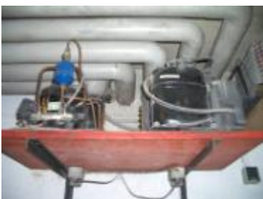
Abbildung 4.4 a- c: Verflüssigungssätze außerhalb des Technikraumes
