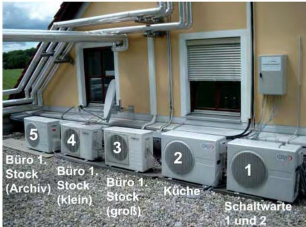
**Abbildung 37: Außeneinheiten der Raumklimageräte und Raumzuordnung**
