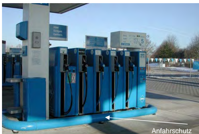
Abbildung 8: CNG-Abgabeeinrichtung nach ÖVGW G97 mit Anfahrerschutz (Bild: ARAL AG)
