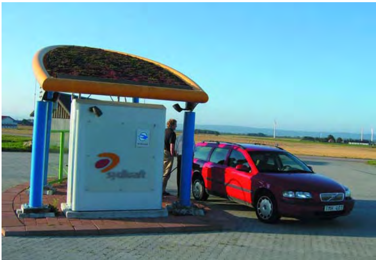
Abbildung 10: Biogas-Tankstelle in Laholm (TRETTER, 2008a)
