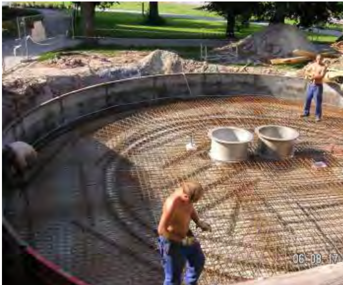
Bewehrungsarbeiten Fermenterdecke inkl. Einstiegsschächte in Edelstahl
