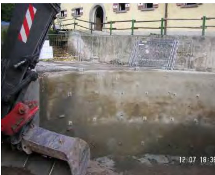
Fertige Baugrubensicherung in Spritzbeton
