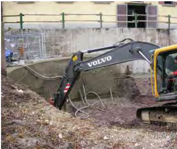
Baugrubenaushub mit vernagelter Spritzbetonsicherung
