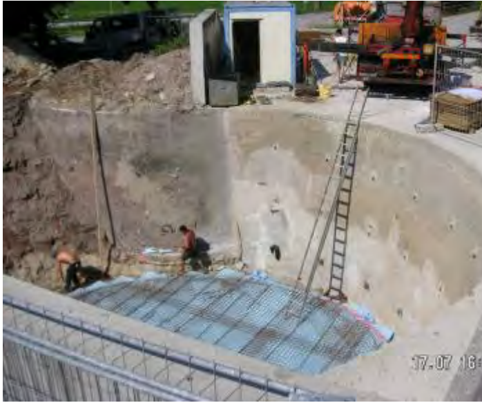
Bewehrungsarbeiten für die Bodenplatte
