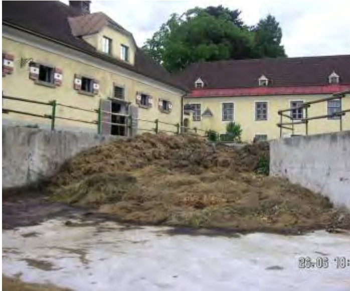
Baufeld für den geplanten Fermenter
