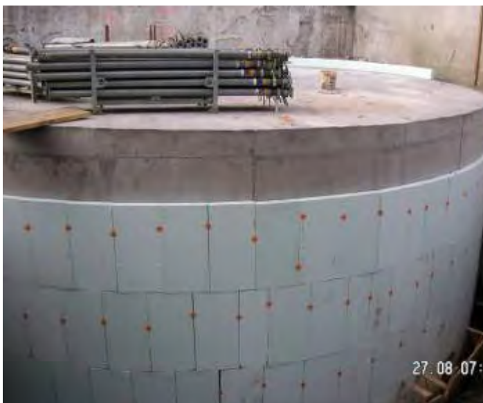
Dämmarbeiten Fermenterwände
