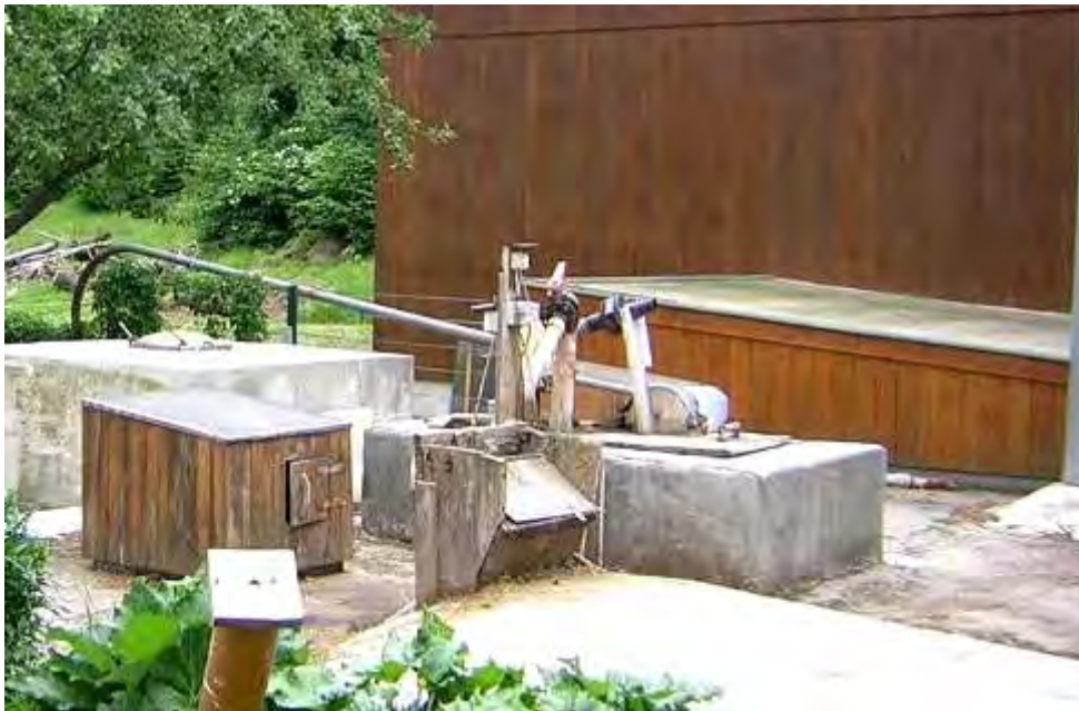
Abbildung 1: Ansicht der analysierten Bestandsbiogasanlage
