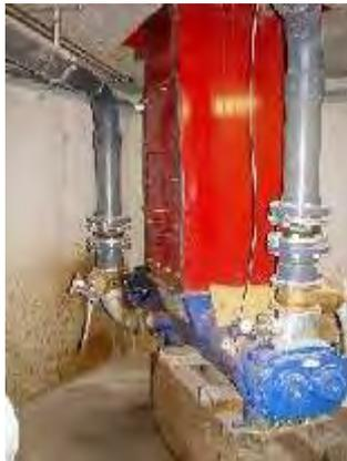
Abbildung 9: Fallschacht zur Einspülpumpe mit Ultraschall
