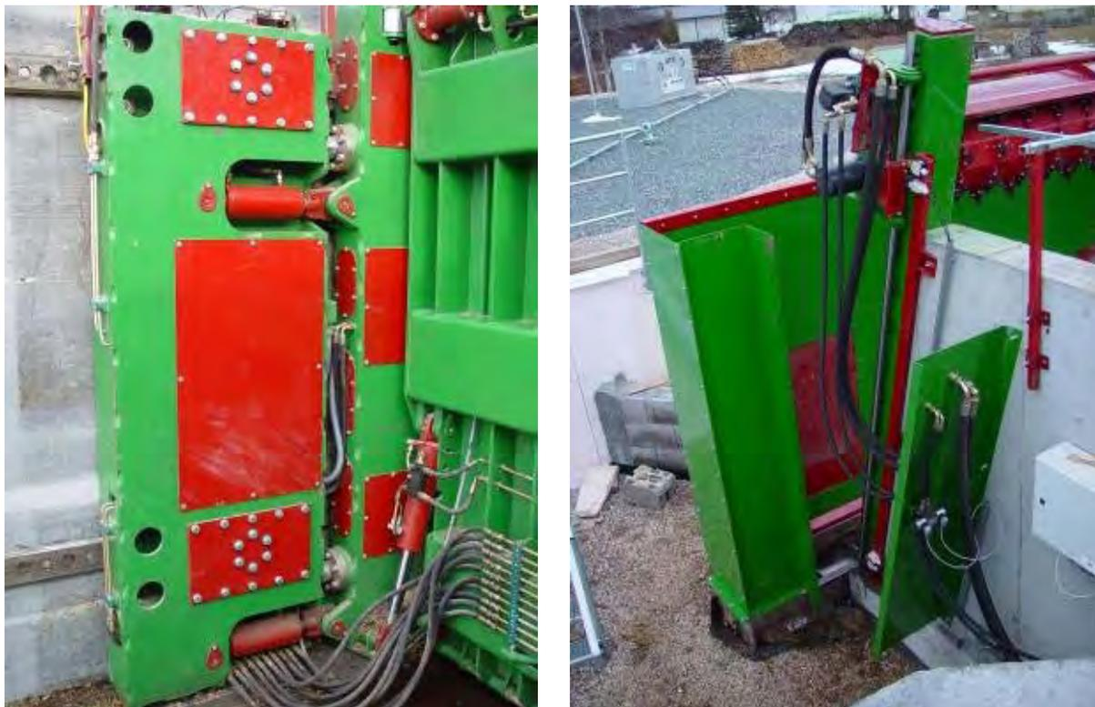
Abbildung 29: Einbau der neuen Führungsschlitten und Anpassung der Fräsleitung an die Förderpumpe für die Fermenterbeschickung
