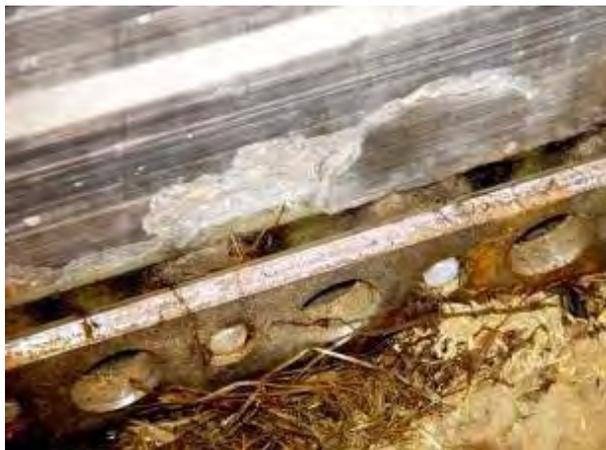
Abbildung 23: Abbruchstellen bei Betonbau und dadurch Toleranzen bei den Seitenführungen und der Absteckzylinder
