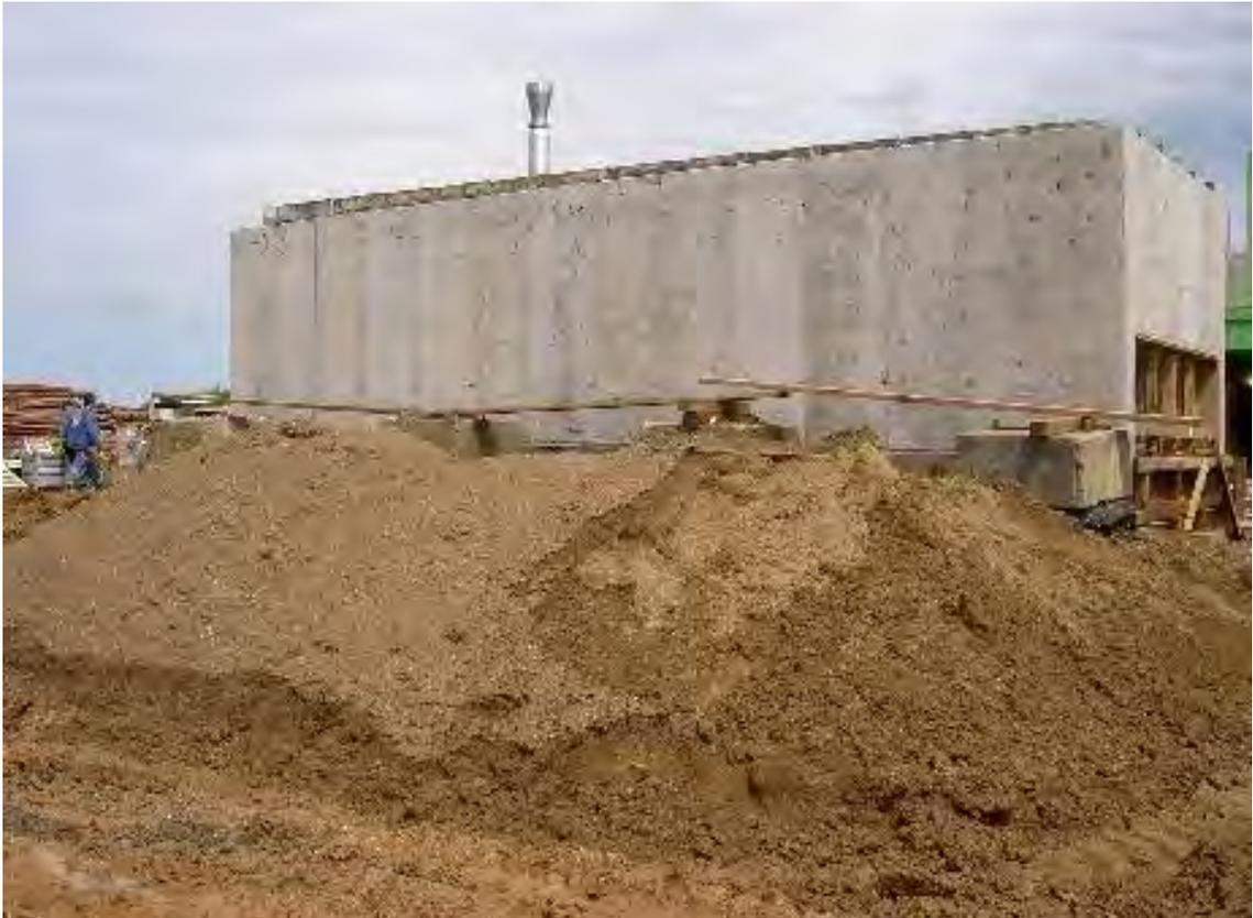
Abbildung 3: Feststoffbehälter in Betonbauweise nach vorgegebenem Schalungsplan
