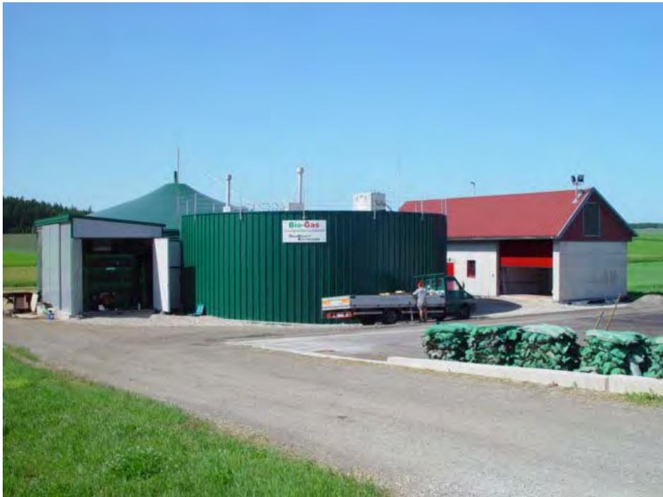
Abbildung 1: Einbringsystem für Biogasanlage mit befahrbarem Feststoffbehälter in Betonausführung
