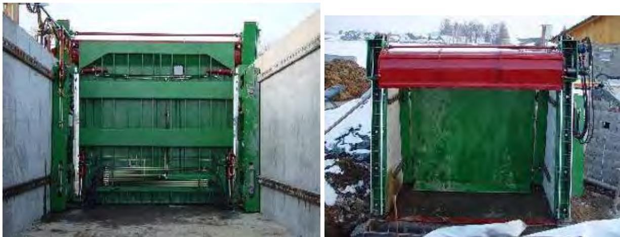
Abbildung 19: Montage der Seitenführungen, Abschiebewand, Fräse und der Querförderschnecke
