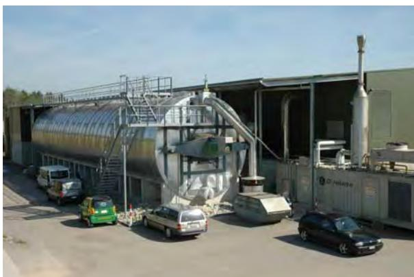
Abbildung 3: Kompogas Bioabfallvergärungsanlage Krüzelen, Schweiz mit 750 m<sup>3</sup> liegendem Faulbehälter ( $T = 54^{\circ} \text{C}$ ), Container mit Gasverstromung (350 kW<sub>el.</sub>), Notfackel und Betriebshalle (Hintergrund). Verarbeitungskapazität 30.000 t/a Frischmaterial, Kompostproduktion: 10.000 t/a.
