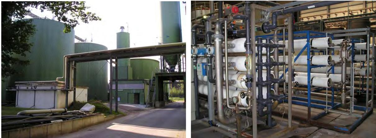
Abbildung 8: Agrar Bio-Recycling Biogasanlage Wietzendorf, Deutschland mit Bio gasreaktoren (links) und Mikrofiltrations- / Umkehrosmoseanlage zur Faulwasseraufbereitung
