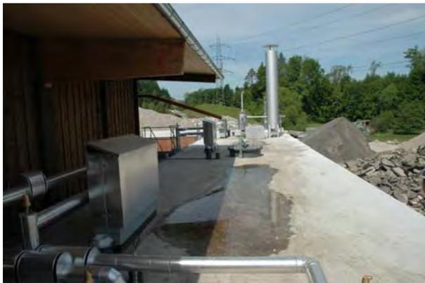
Abbildung 4: Kompogas Bioabfallvergärungsanlage Engelhölzli mit betoniertem, kanalförmigem Faulbehälter (V=500 m<sup>3</sup>), Verarbeitungskapazität 15.000 t/a Frischmaterial, Kompostproduktion 5.000 t/a.
