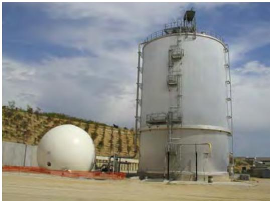
Abbildung 1: Kommunale Vergärungsanlage der Stadt Rom, Malagrotto, System DRANCO, mit Reaktor und externem Ballon Gasspeicher
