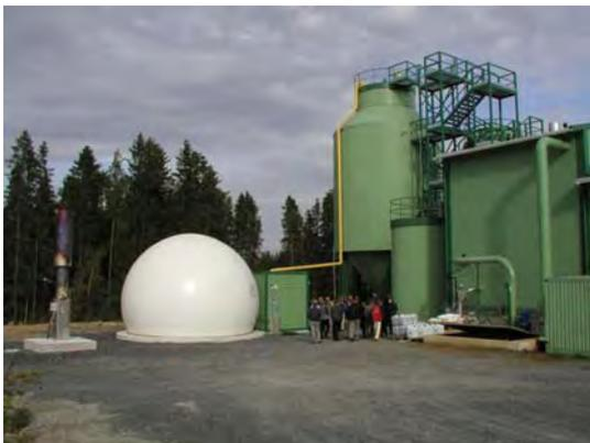
Abbildung 2: Kommunale Bioabfall Vergärungsanlage Laihia, Finnland, System WABIO mit Maschinenraum, Reaktor, Ballongasspeicher und Biogasnotfackel
