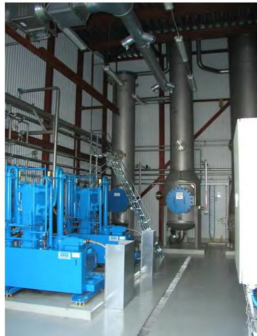
Abbildung 7: Växkraft Biogasanlage Västerås, Schweden mit Biogasreaktor (links) und Biogasaufbereitung zu Treibstoff (rechts)
