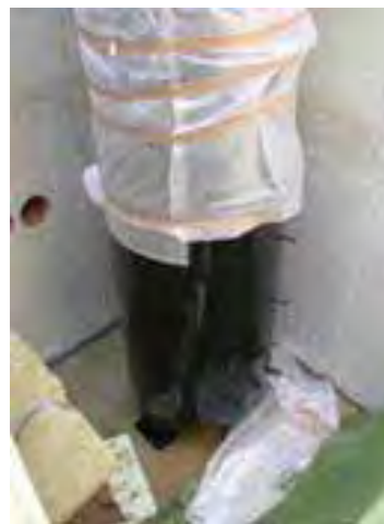
Abbildung 5: Einbringung eines großen Pufferspeichers (Quelle: GSWB)
