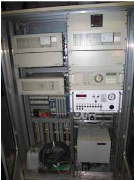
Abbildung 8.1: Abgasmessschrank
