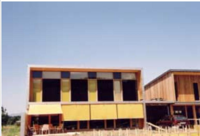
Abbildung 2: 28 m<sup>2</sup> Kollektorfläche in der Fassade eines Holzriegelbaus, Brauchwasserbereitung und Raumheizung. Die Glasabdeckleisten sind aus Holz. (Foto: DOMA Solartechnik)
