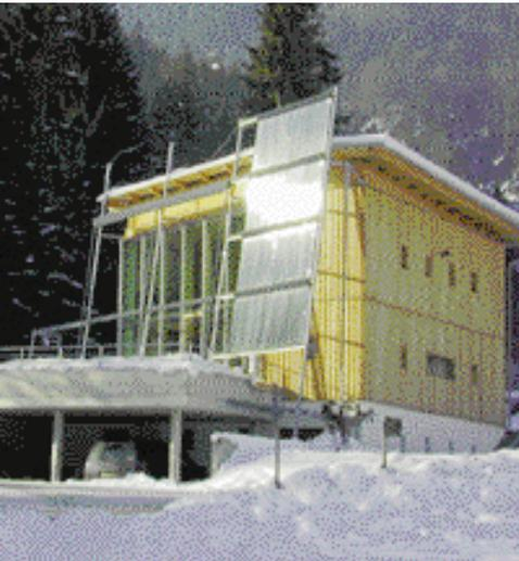
Die architektonischen Grundelemente dieses Hauses sind der schlichte, mit unbehandeltem Lärchenholz verschaltete, zu drei Seiten verschlossene Baukörper, die vorgesetzte schwebende Terrasse, die sichtgeschützten Außenräume sowie die das Haus nach Süden öffnende Glasfassade mit dem vorgesetzten Stahlgerüst und den darauf bewusst gezeigten technischen Elementen.
