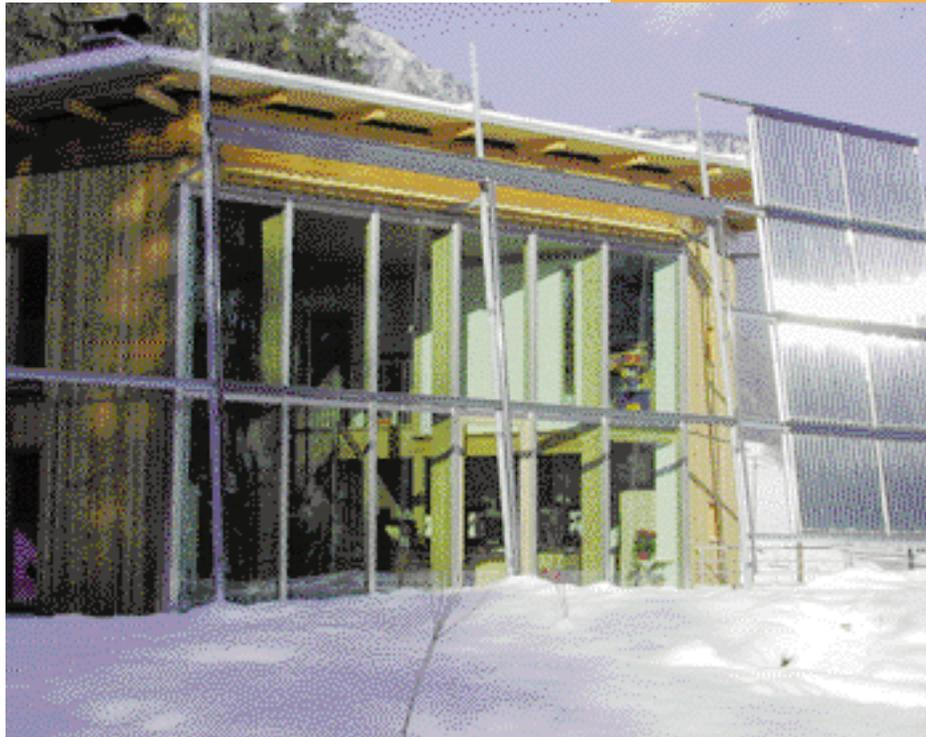
**Dieses Einfamilienhaus im Passivhausstandard zeichnet sich besonders durch seinen einfachen Baukörper und die bewusst gezeigten Solarkollektoren auf einer Stahlkonstruktion aus.**
