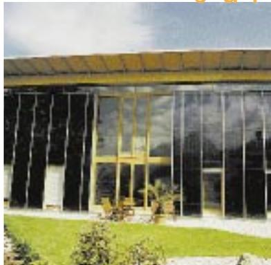
*Der Name ist vielversprechend. Auch wenn er nicht ganz erfüllt wird, ist das Ergebnis respektabel. Ein sehr niedriger Heizwärmebedarf wird erreicht durch eine kompakte Bauform, eine konsequente Ausrichtung nach Süden und die für diese Gebäudekategorie erforderliche Wärmedämmung und Fensterqualität.*
