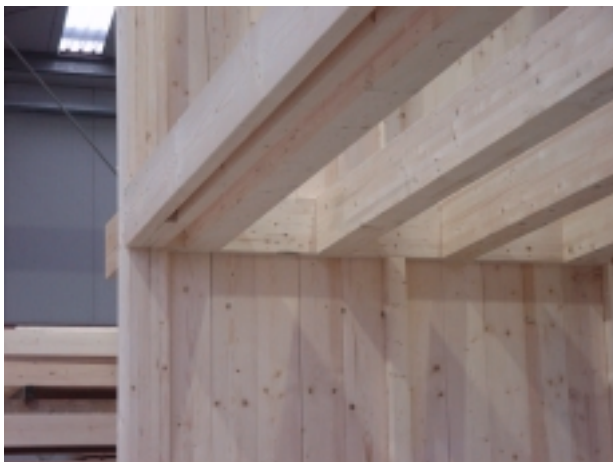
Abb. 8.3.2: Einbau der „Schwerter“ aus Furnierschichtholz und der Vorspannkeile
