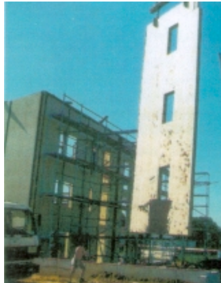
Abb. 2.18: Versetzen einer gebäudehohen verleimten Massivholzwand: Wohnanlage Aichach, Arch. Widmann/ Schröder, Tragwerksplanung und ausführende Firma: Merk [Quelle: Prospekt Firma Merk]
