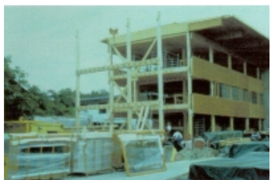
Abb. 2.22: Modernes Beispiel einer „hochgeklappten“ Skelettkonstruktion: Bürogebäude Firma Schrattecker, Lohnsburg, Arch. Riepl & Riepl, Tragwerksplanung: Prof. Winter, DI Woschitz, Firma Obermayr Holzkonstruktionen GmbH, [Quelle: Prof. Winter]
