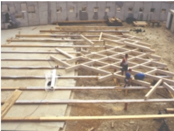
Abb. 2.23: 5 Lagen von bewehrten Betonplattendecken ohne Unterzüge die ebenerdig im „Youtz-Lift-Slab-System“ in übereinander liegenden Schichten hergestellt wurden, werden simultan hochgezogen, wobei jeweilig die Stützen um die Etagenlänge anmontiert werden.[Quelle: unbekannt]
