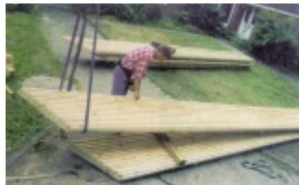
Abb. 2.19: Gebäudehohe vernagelte Brettstapelwand als Giebelwand bei einer Skelettkonstruktion: Eine-Welt-Kirche, Schneverdingen, Arch. Tabery, Ingenieurbüro IEZ Natterer, [Quelle: IEZ Natterer]
