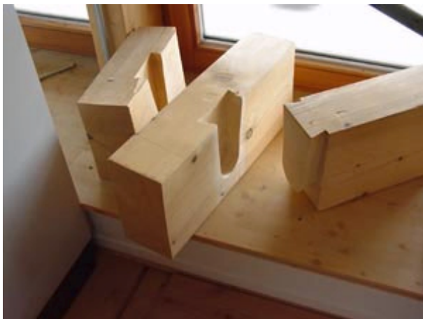
Abb. 5.6: konische Schwalbenschwanzverbindung bei einem Bauvorhaben Fa. Ettwein
