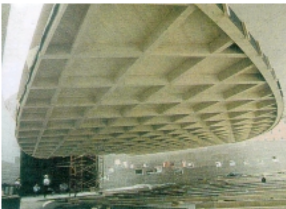
Abb. 2.24: Zusammenbau der vorkonfektionierten (pre cut) Einzelelemente auf dem Boden und anschließendes Einheben des gesamten Daches, Netzkonstruktion des Holzdaches der Kirche St. Benedikt, 1110 Wien, Arch.
