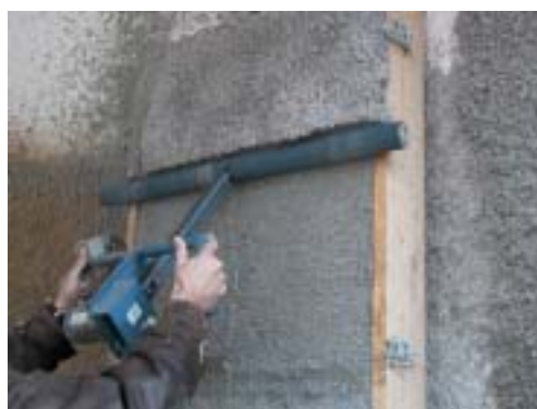
Abb. 14 Abziehen der aufgespritzten Dämmschicht
