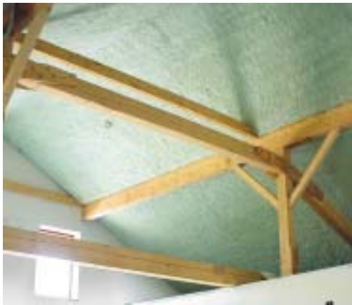
Abb. 71 Aufgespritzte Akustikbeschichtung
