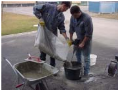
Abb. 61 Anrühren des Putzes
