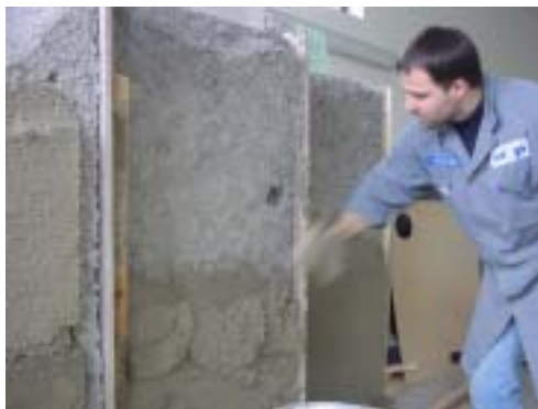
Abb. 62 Anwurf von ThermoExtra
