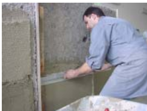
Abb. 63 Abziehen der Putzschichte - ThermoExtra
