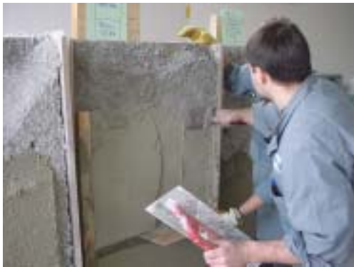
Abb. 64 "Vorstreichen" einer dünnen Putzschicht
