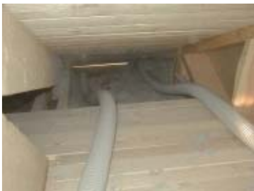
Abb. 13 Einblasen einer Dachschräge vom Spitzboden aus
