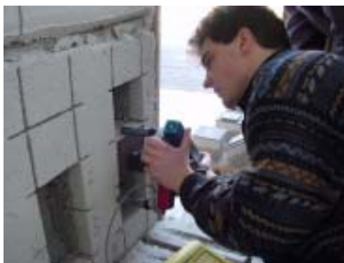
Abb. 68 Ansetzen des Prüfgerätes
