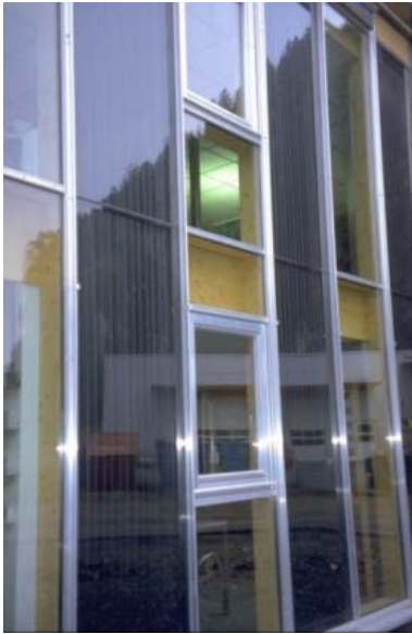
Abbildung A 1.53: Detailansicht der Fassade mit integrierten Kollektoren
