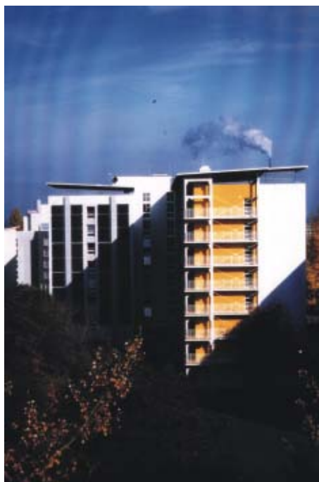
Abbildung 5.12: Teilweise Abschattung der Kollektorfläche auf dem rückwärtigen Gebäude durch angrenzende Gebäudeteile, [Lit 16]. Schattenwurf an einem Vormittag im Spätherbst.
