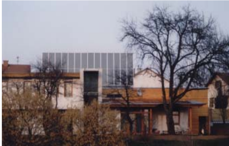
Abbildung A 1.17: Einfamilienhaus B2
