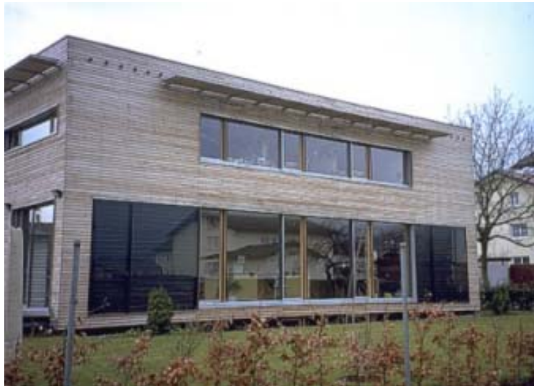
Abbildung A 1.23: Südansicht des Objektes B4 mit den Fassadenkollektoren
