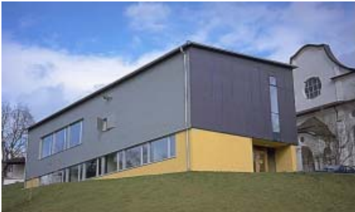
Abbildung A 1.5: Ansicht der Kollektorsüdfassade, Anlage A2
