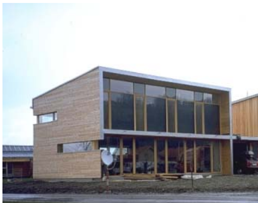
Abbildung 3.3: Südansicht des Objektes B3 mit den Fassadenkollektoren im Obergeschoss
