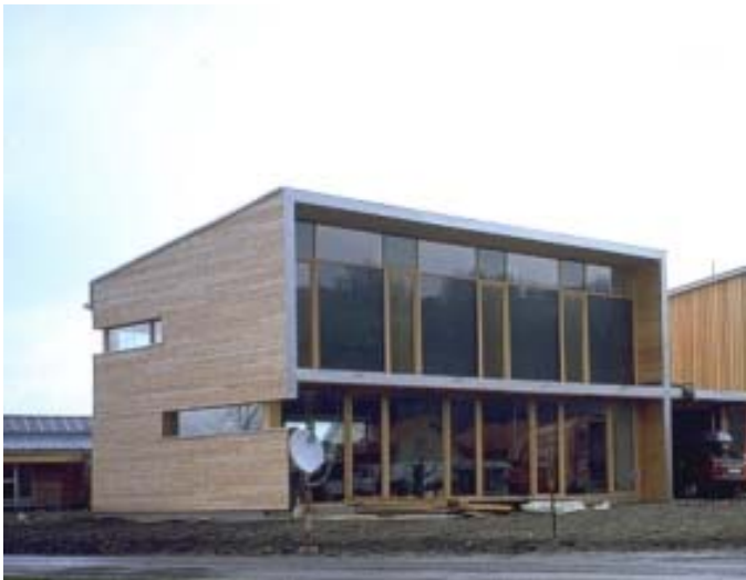
Abbildung A 1.19: Südansicht mit den Fassadenkollektoren im Obergeschoss, Anlage B3
