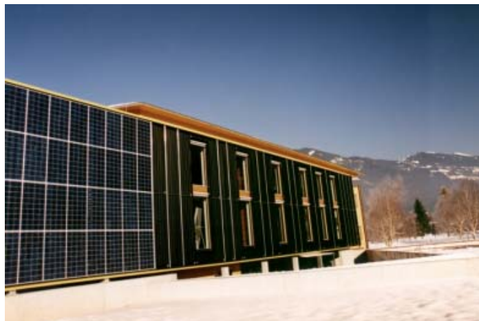
Abbildung A 1.43: Südansicht des Bürogebäudes C1 mit integrierten Fassadenkollektoren und Photovoltaikmodulen
