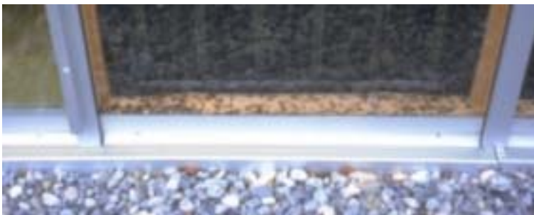
Abbildung A 1.16: Insekten im Kollektor
