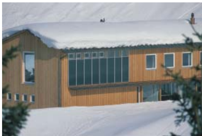
Abbildung 5.6: Fassadenkollektoranlage, Arlberg, Foto: AKS DOMA Solartechnik
