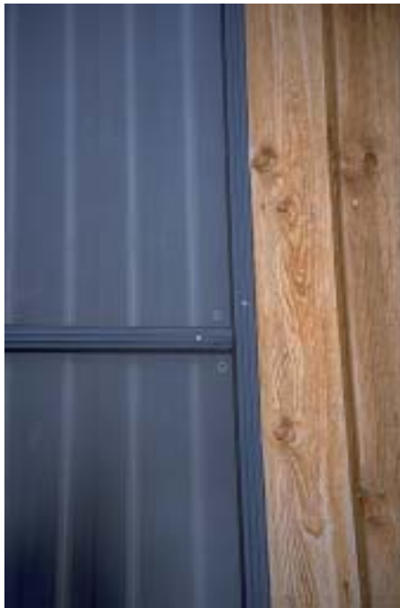
Abbildung A 1.38: Vertikale und horizontale Glasbefestigungsprofile
