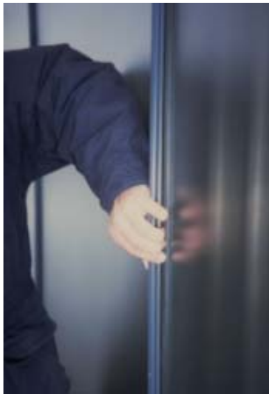
Abbildung 3.5: Einige Schrauben des Alu-Abdeckprofils sind durch die Windsogbelastung gelockert bzw. fehlen
