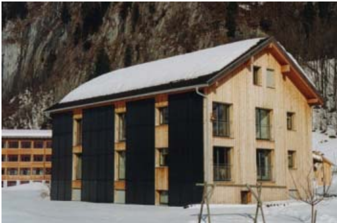
Abbildung A 1.35: Südansicht des Zweifamilienhauses B7 mit Fassadenkollektor
