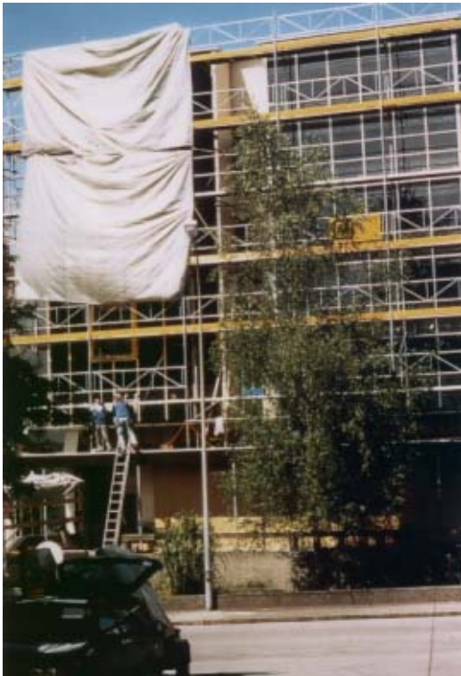
Abbildung A 1.11: Vor Ort Montage der Kollektorfassade
