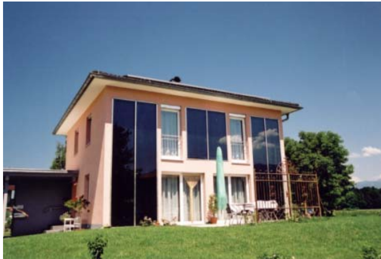
Abbildung A 1.31: Südansicht des Objektes B6 mit den Fassadenkollektoren. Ein Kollektorfeld wurde zwischen den beiden Fenstern im Obergeschoss montiert.
