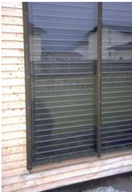
Abbildung A 1.25: Detailansicht des Fassadenkollektors
