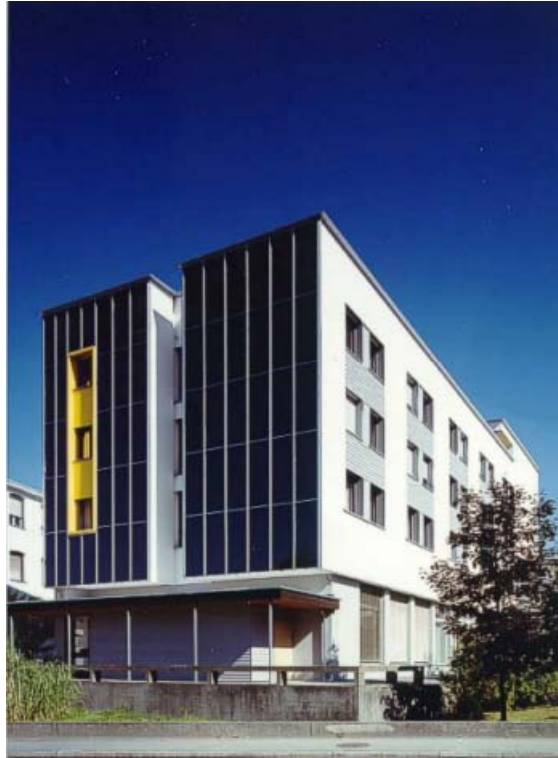
Abbildung A 1.9: Ansicht der Kollektorsüdfassade des Öffentlichen Objektes A3
