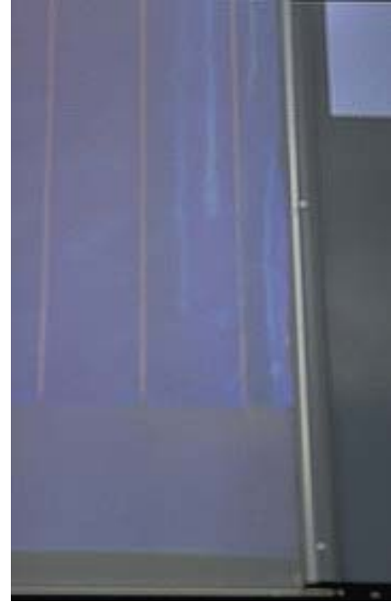
Abbildung 3.7: Detailansicht des Absorberfeldes: Durch Nässe beim Absorber-einbau sind Schlieren am Absorber sichtbar.
