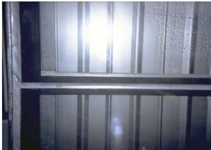
Abbildung A 1.3: Der Kollektorausschnitt zeigt die Absorberstreifen und die mit Silikon eingedichteten Gläser.
