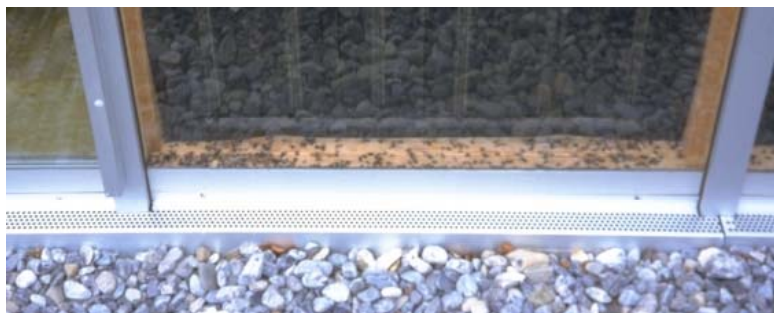
Abbildung 3.8: Insekten im Kollektor
