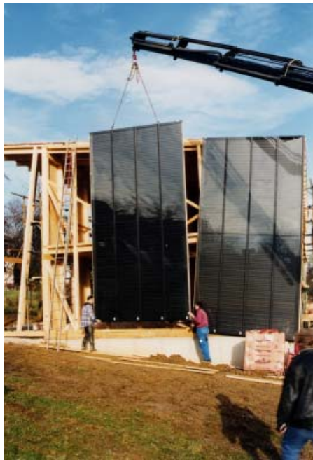
Abbildung 7.2: Montage der Kollektoren mit Hilfe eines Kranes. Das Kollektorfeld besteht aus drei Elementen zu je 18,3 m 2 .
