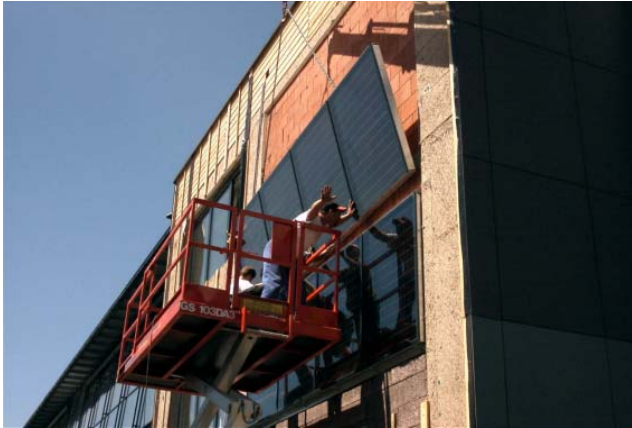
Abbildung 7.24: Montage des Versuchskollektors mit einem Kran.
