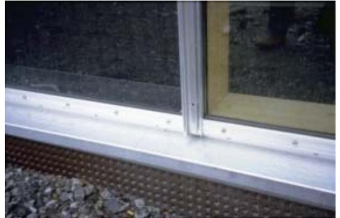
Abbildung A 1.54: Detailansicht Glasbefestigung unten. Bei dieser Anlage werden nicht Glashaltewinkel, wie sonst üblich, sondern Alu-Abdeckprofile für die Glasfixierung verwendet.
