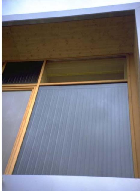
Abbildung A 1.21: Detailansicht des Kollektorfeldes mit Holzabdeckkleisten
