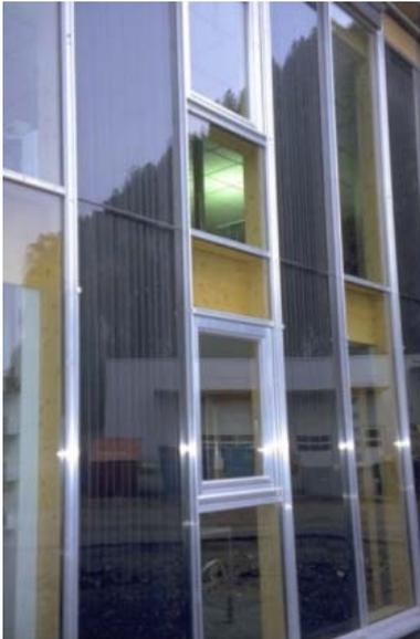
Abbildung A 1.53: Detailansicht der Fassade mit integrierten Kollektoren
