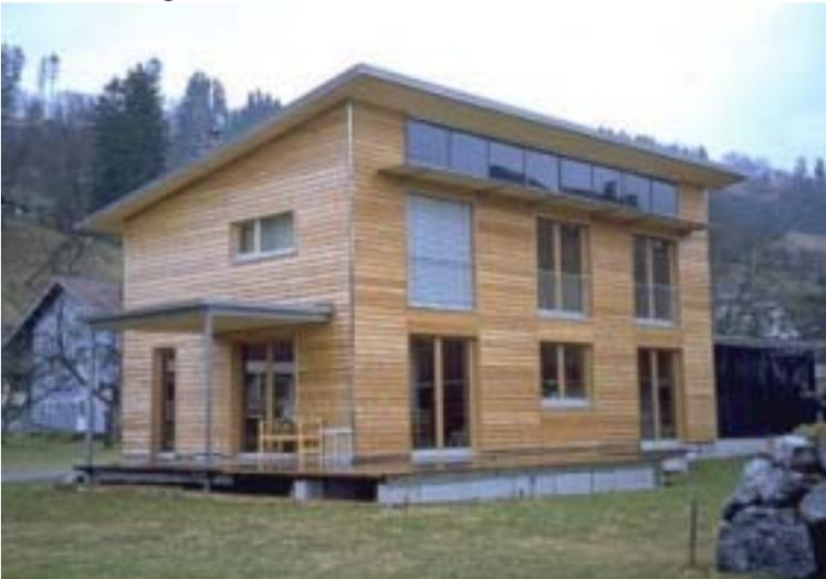
die zweite Teilfläche in die Fassade des Wohnhauses integriert ist. Die Kollektoren wurden als Fertigmodule geliefert. Die Eckdaten der Anlage sind in Tabelle A 1.15 zusammengefasst.
