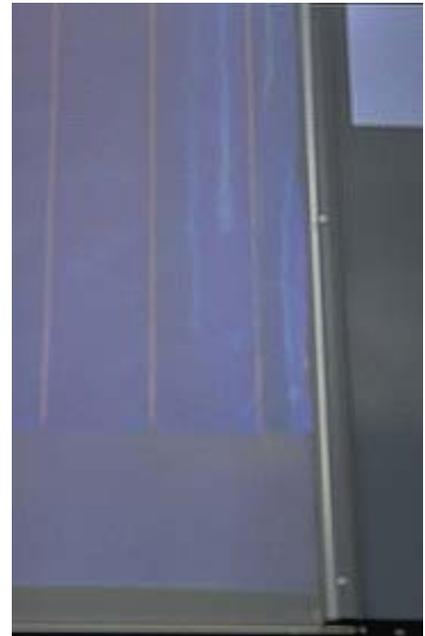
Abbildung A 1.8: Detailansicht des Absorberfeldes, durch Nässe beim Absorbereinbau sind Schlieren am Absorber sichtbar.
