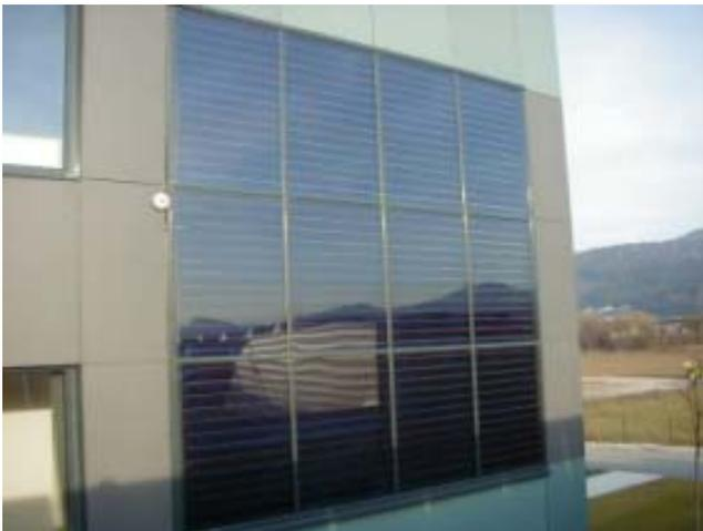
Abbildung 7.25: Versuchskollektor, 24,7 m<sup>2</sup> Bruttokollektorfläche über das 1. und 2. OG, Ansicht der Südfassade des Verwaltungsgebäudes
