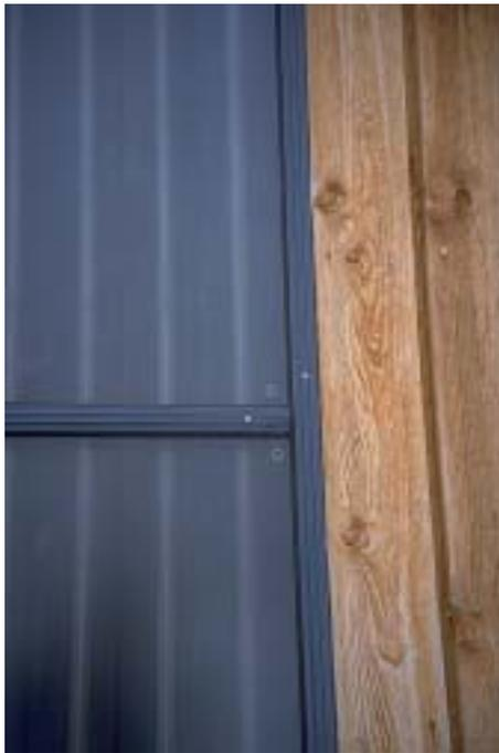
Abbildung A 1.38: Vertikale und horizontale Glasbefestigungsprofile
