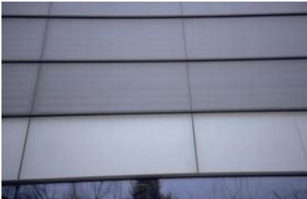
Abbildung A 1.50: Die Südfassade besteht aus den Elementen: Fenster, undurchsichtige Glasfassade und Fassadenkollektor
