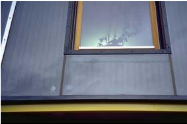
Abbildung A 1.45: Detailausschnitt der Kollektorfassade; mit Fensteranschluss an die Kollektorglasabdeckung
