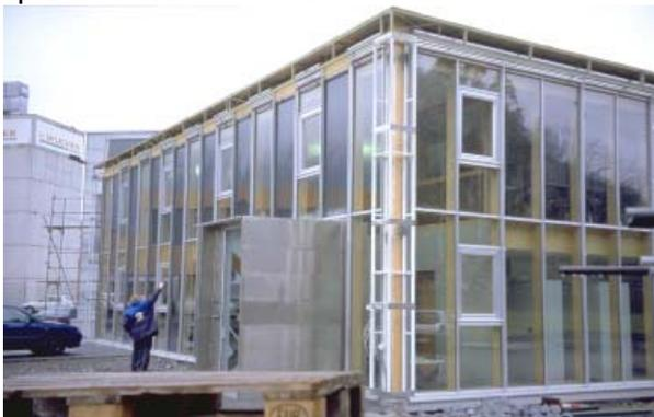
Energieversorgung – Brauchwasserbereitung und Raumheizung – wird vollständig aus erneuerbaren Energieträgern bewerkstelligt. Dies geschieht einerseits durch eine thermische Solaranlage, deren Kollektoren in die Fassade integriert sind, und andererseits durch die Wärmeversorgung über ein Biomassemikronetz.
