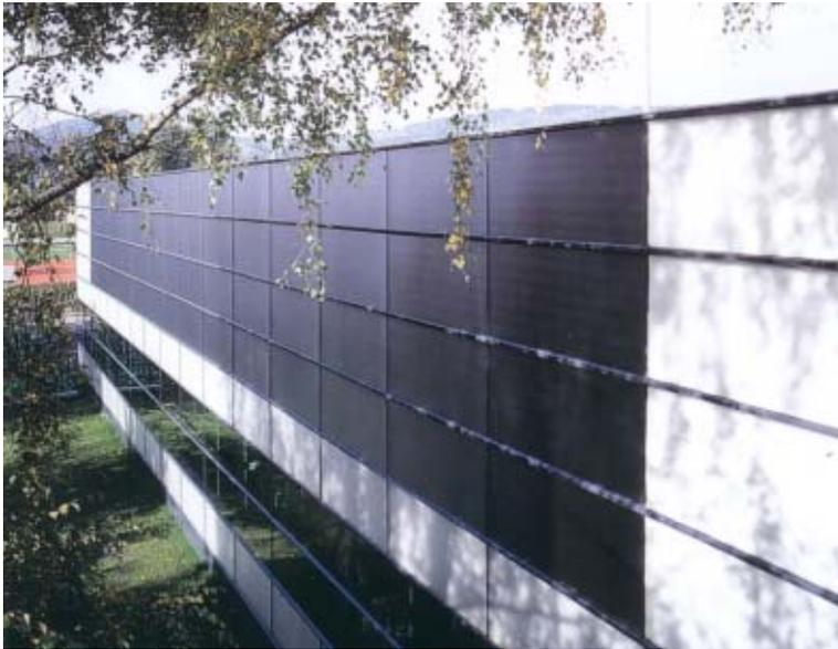
Die Einheit von Form und Funktion harmonieren bei der Produktionshalle der Firma C2 optimal. Verglasung, Wandelemente und fassadenintegrierte Kollektoren sind flächenbündig und gehen nahtlos ineinander über. Die Gebäudehülle ist sehr gut gedämmt. So weisen die Hallendecke eine Dämmstärke von 200 mm und die Wandelemente eine Dämmstärke von 160 mm auf.
