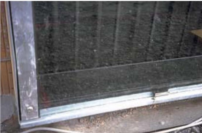
Abbildung A 1.33: Kollektordetail: Absorber, Glashalteprofil, Glashaltewinkel; Abdeckblech für die Sammelleitung. Der Kollektor ist direkt an der Ziegelmauer montiert.
