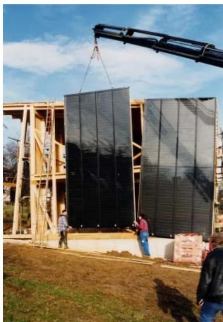
Abbildung 7.2: Montage der Kollektoren mit Hilfe eines Kranes. Das Kollektorfeld besteht aus drei Elementen zu je 18,3 m<sup>2</sup>.
