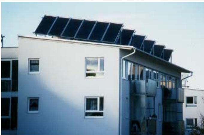
Abbildung 5.15: Abschattung durch aufgeständerte Kollektoren
