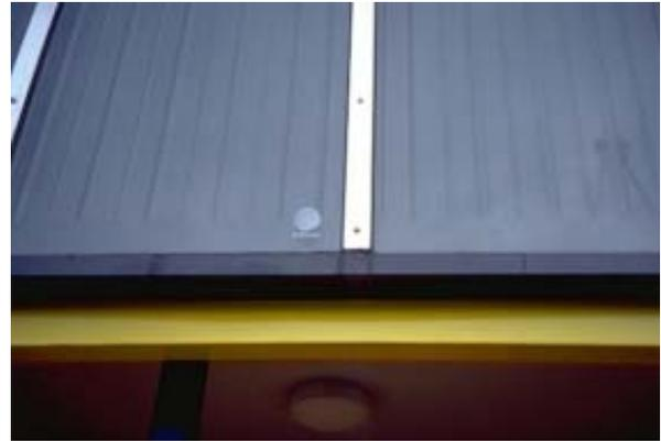
Abbildung A 1.46: Detailausschnitt Kollektor unten; Fixierung der Glasscheiben mit den Alu-Abdeckprofilen und durchgehenden Glashaltewinkel. In diesen sind die Gläser mit Silikon eingedichtet
