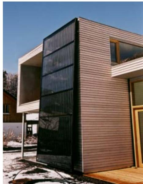
Das Großflächenmodul hat eine Kollektorbruttofläche von 18 m<sup>2</sup>. Die im Kollektor erzeugte Wärmeenergie wird in einen Pufferspeicher eingetragen. Die Kollektorfläche wurde so gewählt, dass sie mit dem Gebäude architektonisch harmonisiert. Die Eckdaten der Anlage sind in Tabelle A 1.1 zusammengefasst.
