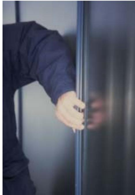
Abbildung A 1.39: Einige Schrauben des Alu-Abdeckprofils sind durch die Windsogbelastung gelockert bzw. fehlen.
