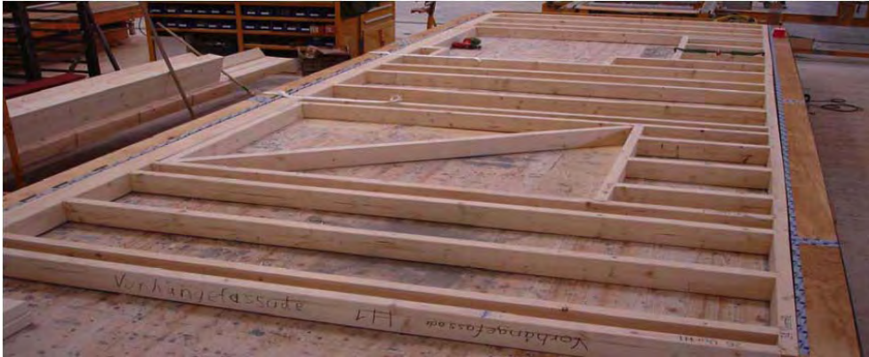
Bad Aibling: Grundkonstruktion Fassadenelemente Südseite, Produktion der Grundkonstruktion. Fotos © Schankula Architekten
