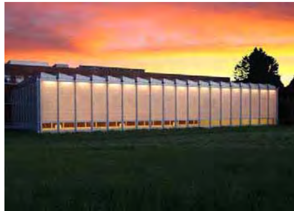
Schulanlage Buchwiesen in Zürich: Erweiterung einer Doppelturnhalle mit transluzenten Aerogel/Nanogel Kunststofffassadenpaneelen. Fotos © amsler-architekten (1-3), Fotos © scobatlit (4)
