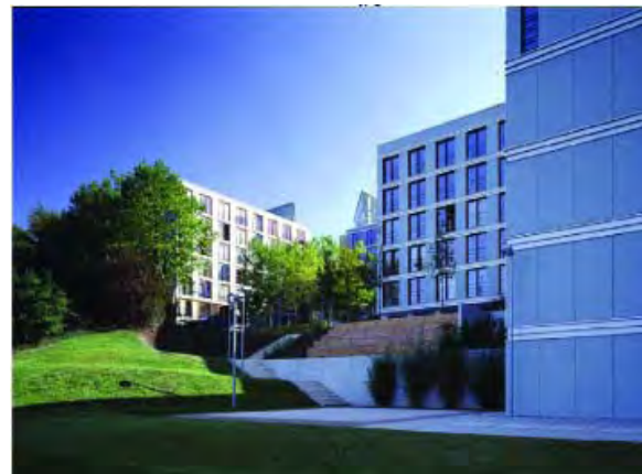
Studentenwohnheim „Neue Burse“: Fassadensanierung mit vorgehängten Holztafelelementen, 2003. Fotos © Tomas Riehle
