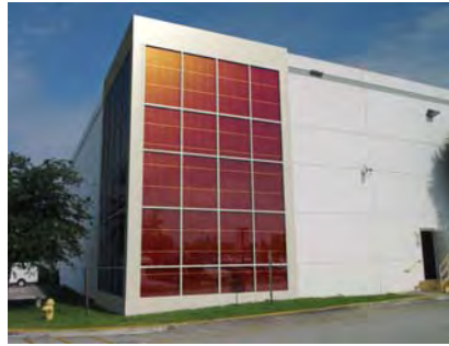
Power Plastic: Kornaka „Power Plastik“ Polymer-Solarzellen, BIPV-Fassadenmodul
