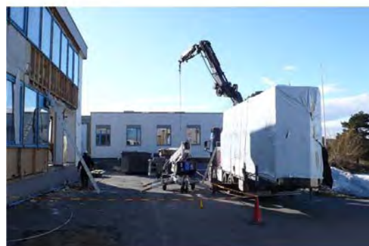
Risør School, Risør Technical College, Norway: Bestand und nach der Sanierung, Demontage der alten Fassadenelemente, Fertigung der neuen Fassadenelemente in der Halle, Anlieferung und Montage. Fotos © Knut Einar Larsen, Liv Ovland (Abb. 2), Arkitektstudio AS/ Trebyggeriet AS
