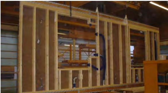
Bad Aibling: Fassadenelement mit montierten Lüftungsleitungen, Luftführung in den Testelementen. Fotos © Schankula Architekten
