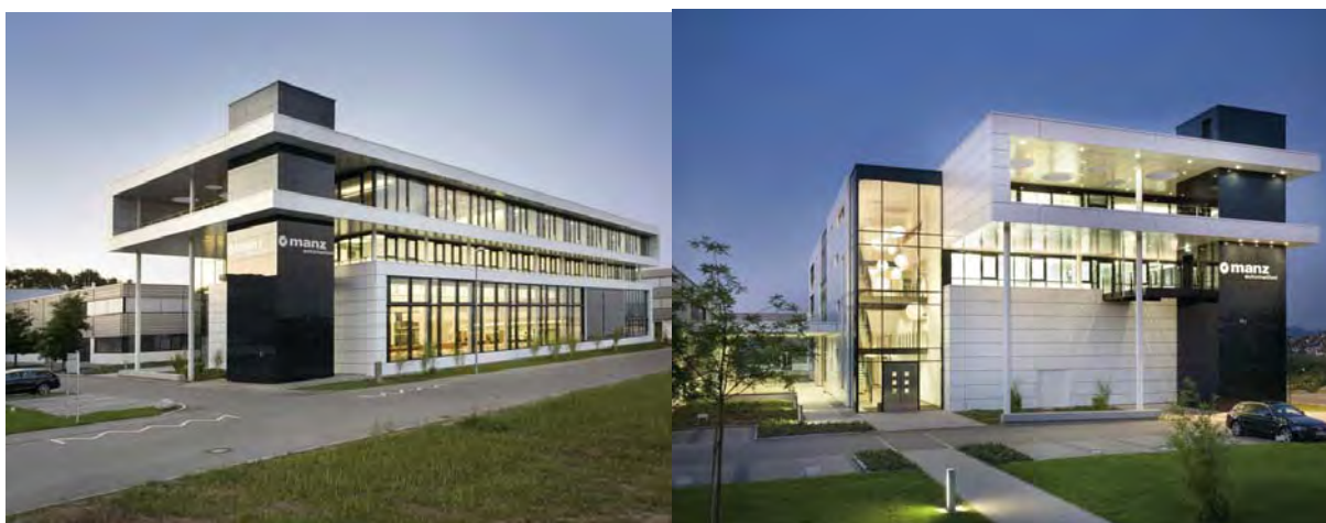
StoVerotec Photovoltaic Testobjekt : Manz Automation AG, Reutlingen/Deutschland, Architekt: HANK + HIRTH Freie Architekten Fotos © Oliver Starke
