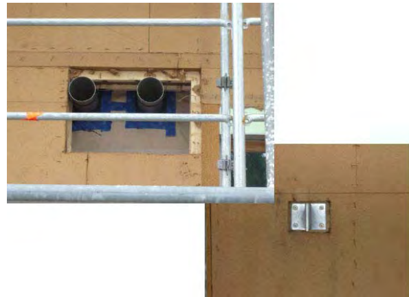
Geschosswohnungsbau Bruckmühl, Fassadenelemente: Produktion, Lieferung und Montage, Einbindung der Leitungen. Fotos © Schaub
