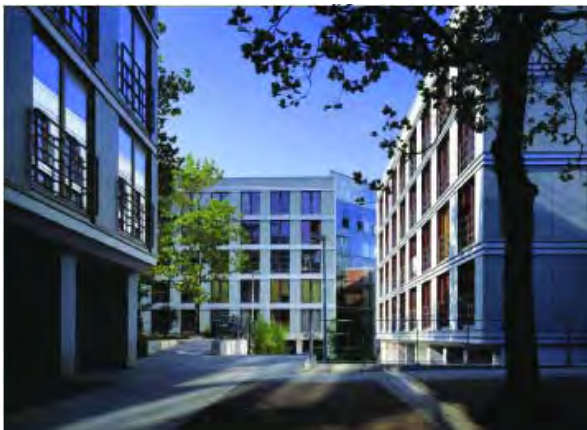
Studentenwohnheim „Neue Burse“: Fassadensanierung mit vorgehängten Holztafelelementen, 2003. Fotos © Tomas Riehle
