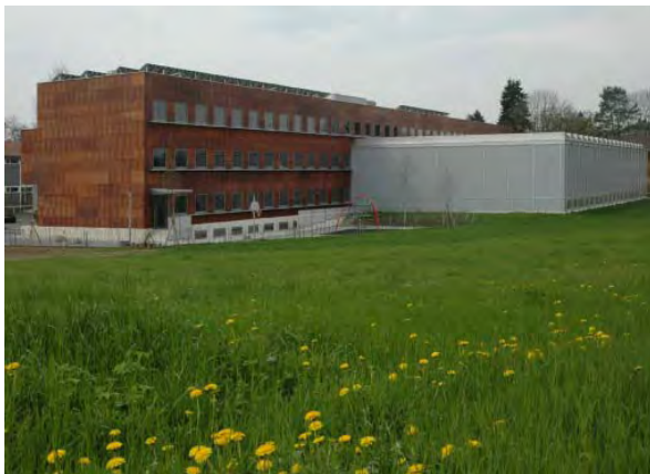
Schulanlage Buchwiesen in Zürich: Erweiterung einer Doppelturnhalle mit transluzenten Aerogel/Nanogel Kunststofffassadenpaneelen. Fotos © amsler-architekten (1-3), Fotos © scobatlit (4)
