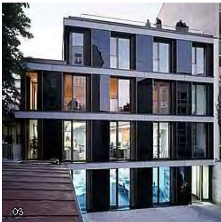
Erweiterungsbau München: Sonnenschutzschiebeladenelemente mit CIS-Dünnschichtmodulen. Foto © a+p Architekten
