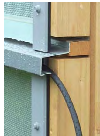
Gap-Solar Fassadenpaneel: Wandaufbau, Funktionsschema, Bauteilschichten und Wanddetail. Grafiken, Fotos © gar-solution
