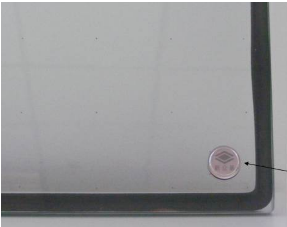
Abb. 43: Der patentierte Getter und das Evakuierungsventil von Synergy unter Abdeckkappe
