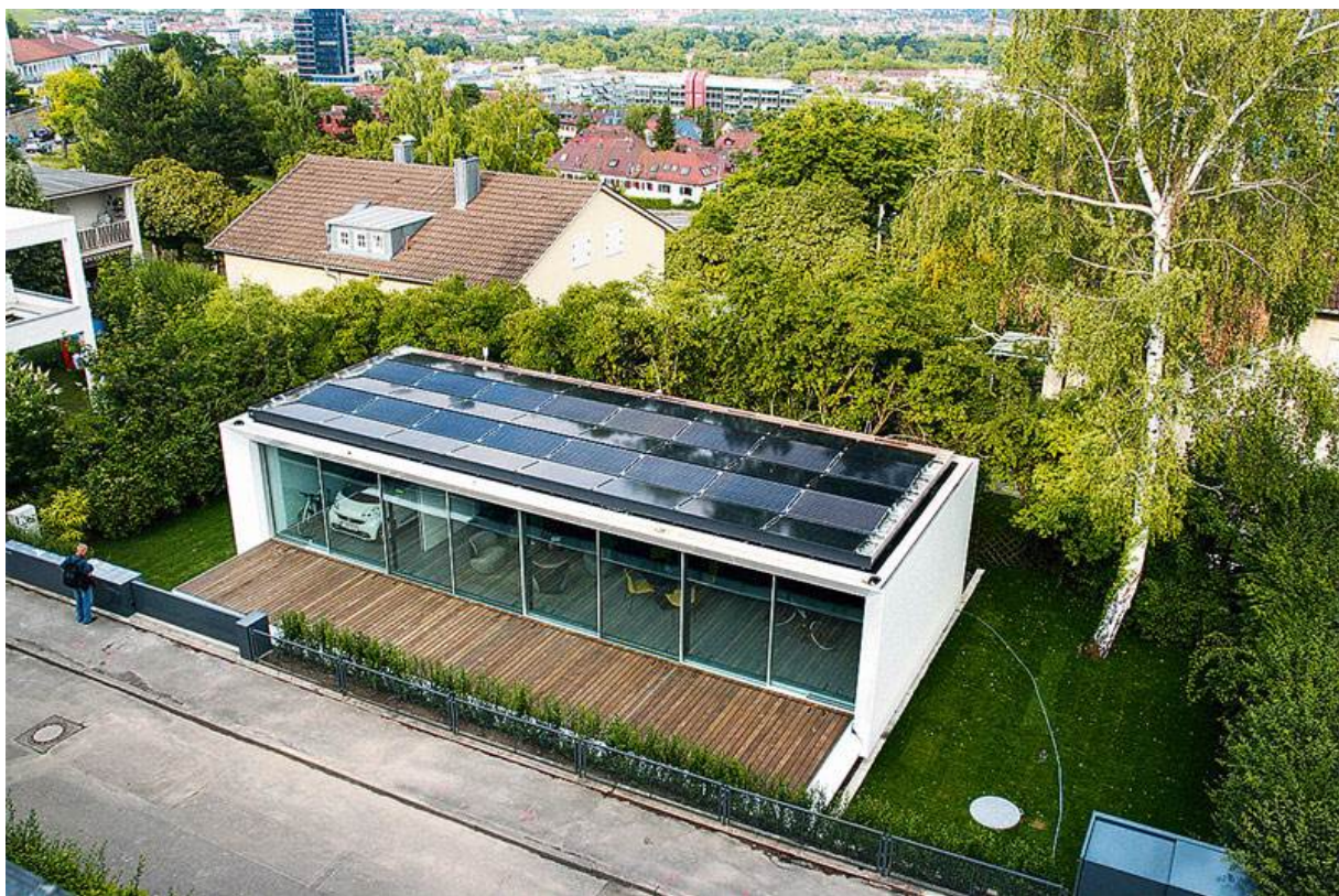
Abbildung 68: Ausgeführten Objekte mit Vakuumglas – Aktiv-Plus-Testhaus Stuttgart [http://derstandard.at/2000004153602/Ein-Haus-als-Gast-in-der-Siedlung]
