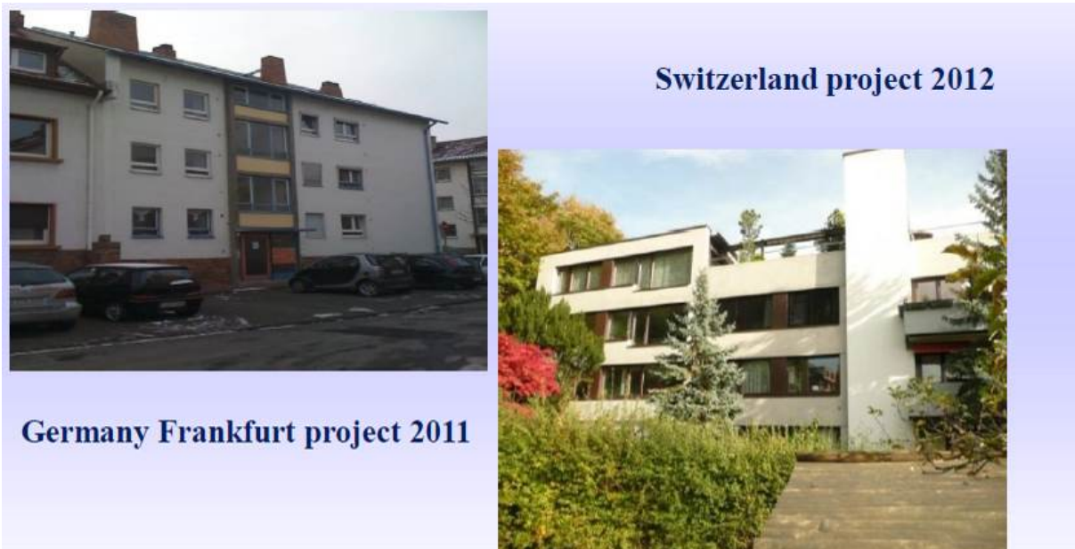
Abbildung 67: Ausgeführten Objekte mit Vakuumglas [H. Hohenstein]
