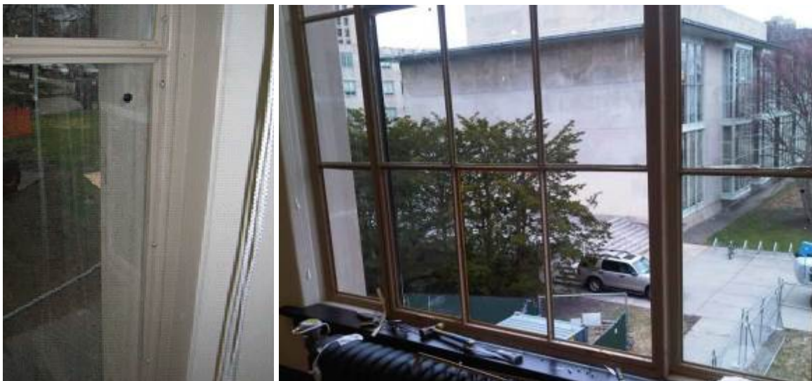
Abb. 35 und 36: Eingebaute VG-Scheiben mit Ventil [www.brikbase.org/sites/default/files/best3_barry.pdf]
