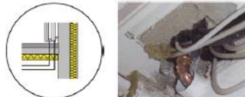
Bild 13: Leitungsführung durch die Kellerdecke
