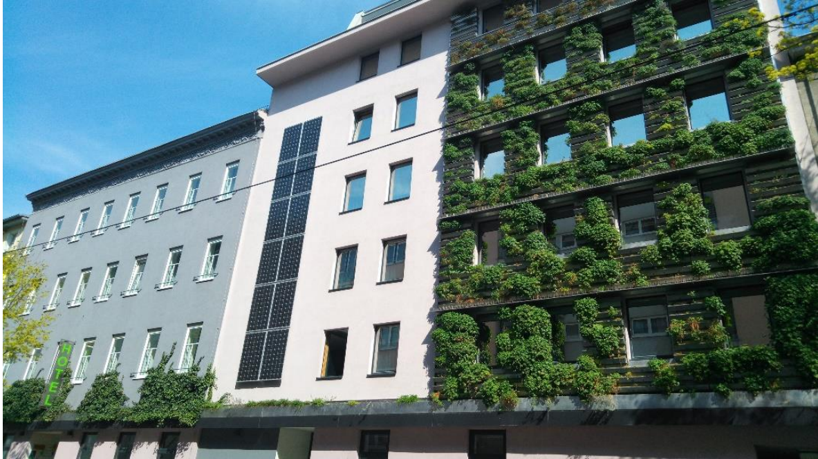
Abbildung 20: Beispiel für geschossweise integrierte horizontale Brandriegel aus Metall (Bildquelle: Dipl.-Ing. Ralf Dopheide e.U., 2020)
