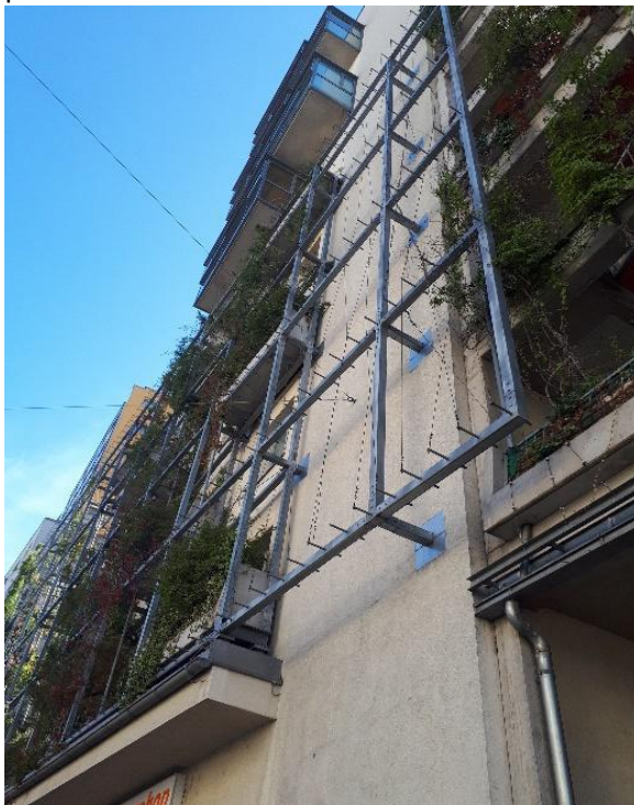
Abbildung 18: Beispiel einer nicht wärmebrückenoptimierten Befestigung der primären Tragkonstruktion der Begrünung (Bildquelle: TU Wien, 2019)
