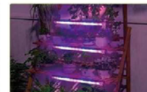
Mit einem Kabelbinder am Regal befestigt
