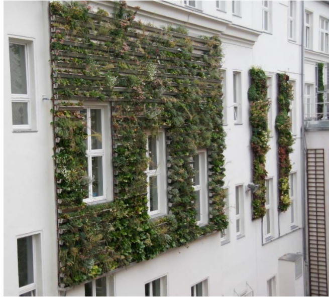
Abbildung 17: Begrünungssysteme im Innenhof des Gymnasiums. Links im Bild: Trogsystem, rechts im Bild: Kassettensystem
