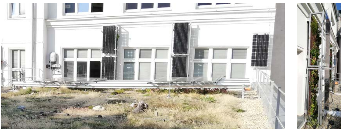
Abbildung 22: Photovoltaikmodule v.l.n.r.: F1 (44 cm Abstand), F2 (25 cm Abstand) und F3 (Referenzmodul) an der Außenfassade (links) & Seitenansicht der Photovoltaikmodule (rechts)
