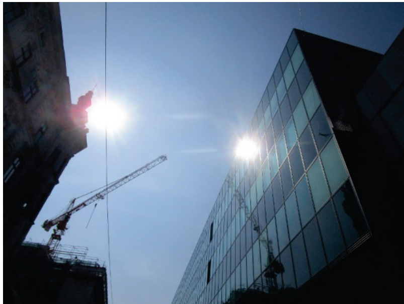
Abbildung 7: „Zweite Sonne“ verursacht durch Glasfassade am TU Wien Gebäude Getreidemarkt 9 (Foto: AIT)
