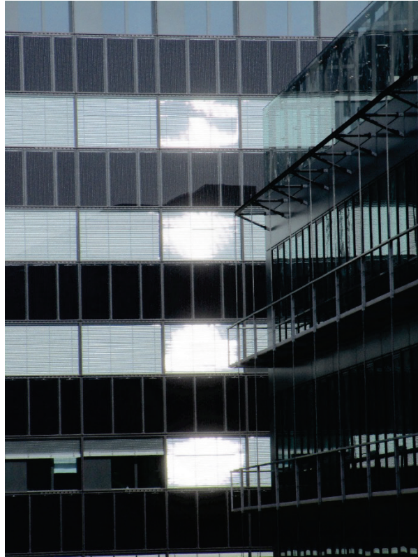
Abbildung 56: Reflexion der Sonne an Glasfassade: Potentielle Blendung an Innenjalousien statt an Photovoltaikmodulen. (Foto: AIT)
