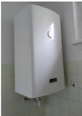
Abbildung 17: E-Boiler wurden erneuert
