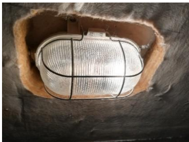
Abbildung 14: Dämmung der Kellerdecke
