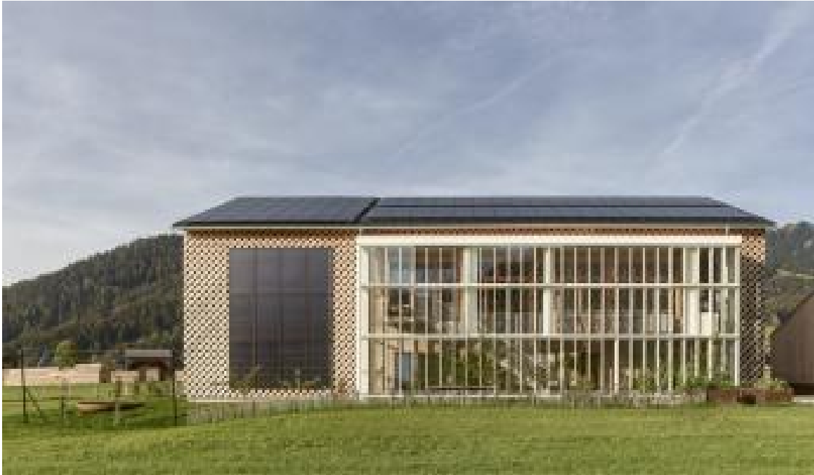
Abbildung 2: Aus einem Kuhstall wird ein Nahezu-Null-Energiehaus (© Kurt Hörbst für BMK / Staatspreis für Architektur und Nachhaltigkeit)
