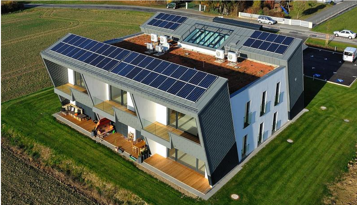
Abbildung 6: Monolithischer Ziegelbau in Kombination vorgelagerter Holzkonstruktion (© Wienerberger Ziegelindustrie GmbH)
