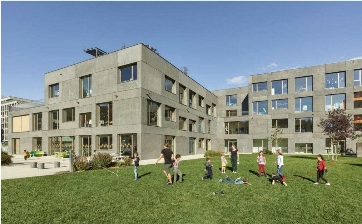
Abbildung 4: Lebendiger Schulcampus in Massivbauweise mit Bauteilaktivierung (© Kurt Hörbst für BMK / Staatspreis für Architektur und Nachhaltigkeit)
