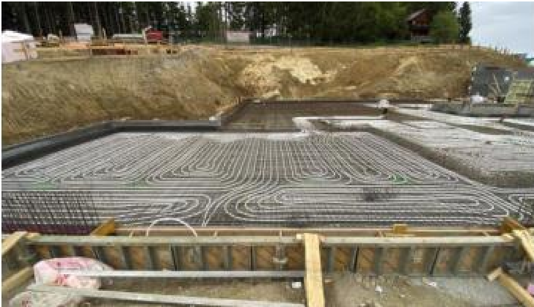
Abbildung 17 Bauteilaktivierung, Quelle: TBH Ingenieur GmbH
