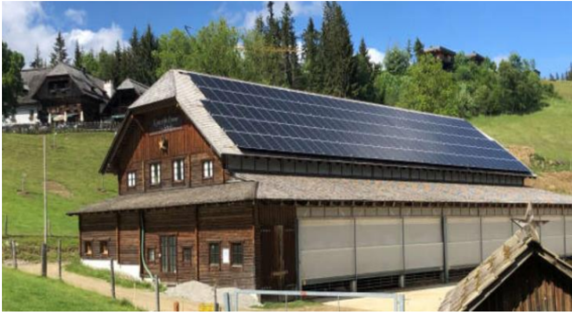
Abbildung 24 Fertigstellung Neue PV-Anlage (66 kWp) auf dem Schafstall, Quelle: AEE INTEC
