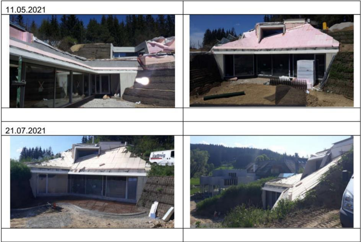
Abb. 1: Baustellenfotos (Quelle: AEE INTEC)
