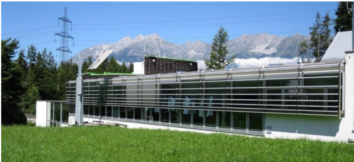
Abbildung 2: Außenansicht der Südfassade des Bartenbach F&E Gebäudes in Aldrans, Österreich
