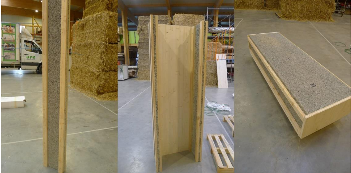
Abbildung 4-35: Herstellung des Wandelements mit HWL-Platten 25mm; Quelle: Eigene Aufnahmen capital [ A ] architects, DPM
