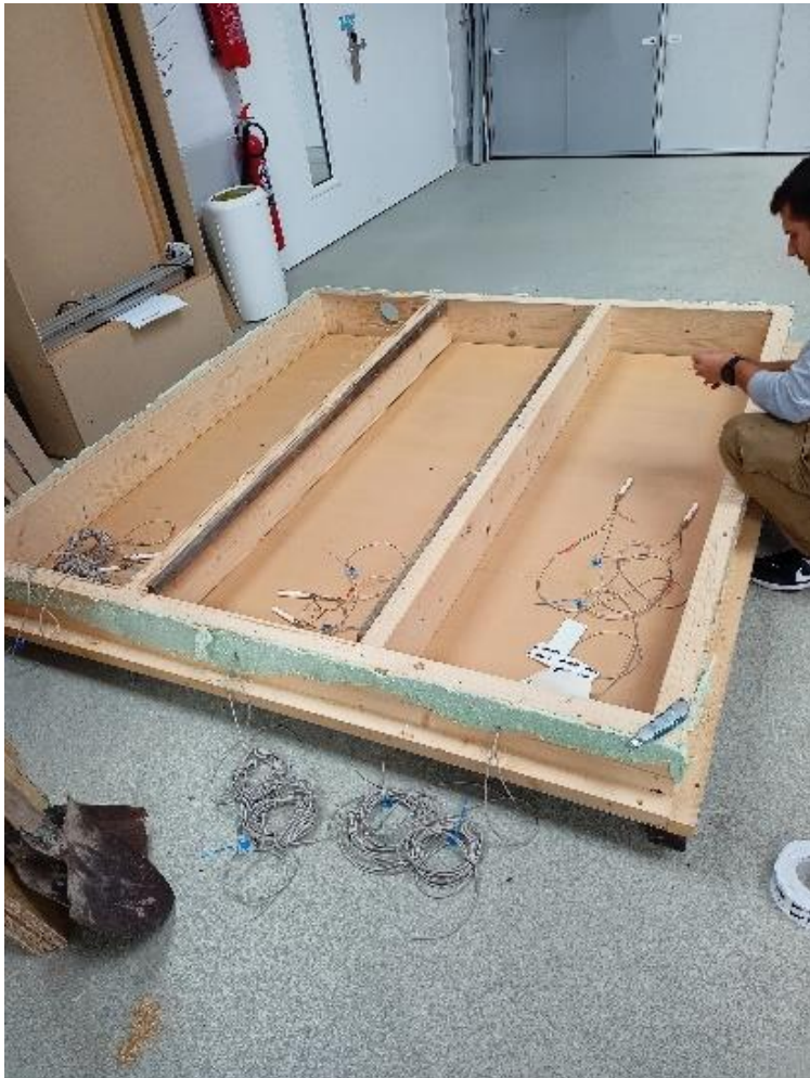
Abbildung 4-53: Wandaufbau mit Feuchte- & Temperatursensoren; Quelle: Eigene Aufnahmen TU Wien
