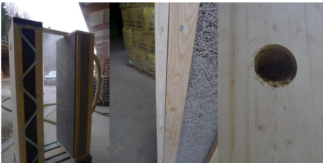
Abbildung 4-38: Staubeentwicklung beim Einblasen (links), intakte Bauteilfugen (mitte) und befülltes Wandelement (rechts); Quelle: Eigene Aufnahmen capital [ A ] architects, DPM
