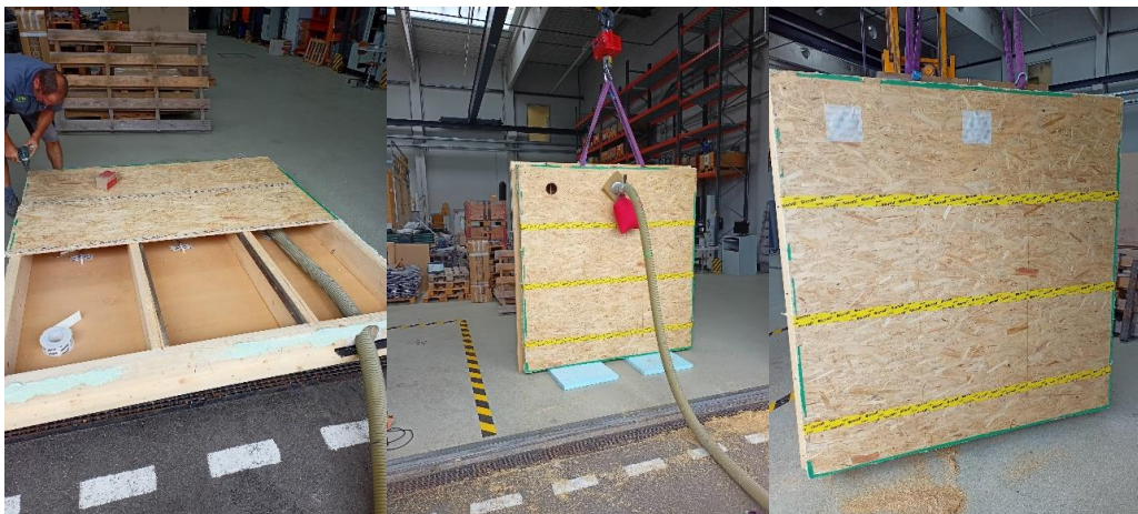
Abbildung 4-55: Noch offenes Bauteil kurz vor dem liegenden Einblasen (links), Stroh wird stehend eingeblasen (mittig), fertiger Wandaufbau (rechts); Quelle: Eigene Aufnahmen TU Wien
