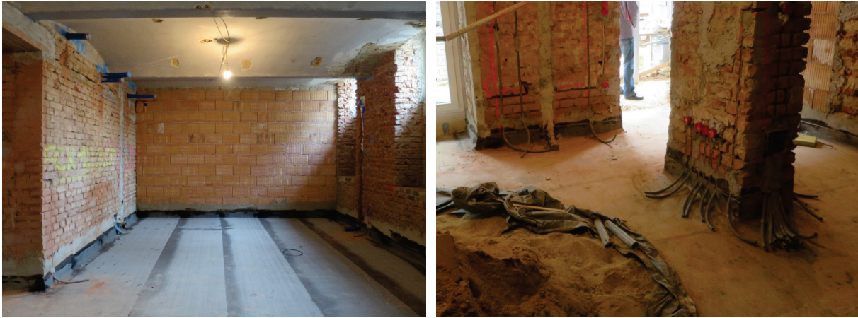
Abbildung 62: Situation am Beginn des Innenausbaus der Souterrain-/Gartenwohnungen im Gebäude B; es ist die abgeflämmte (3-lagige Bitumenabdichtung) Bodenplatte sowie der umlaufende Hochzug der Abdichtung zu sehen; im rechten Foto sind Durchdringungen des Hochzugs dokumentiert;
