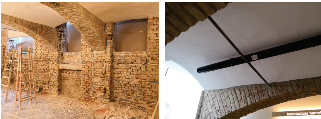
Abbildung 14: Kellermauerwerk ohne Verputz mit Wandtemperierung (links); fertige Sanierung mit Lüftungsleitung (rechts)
