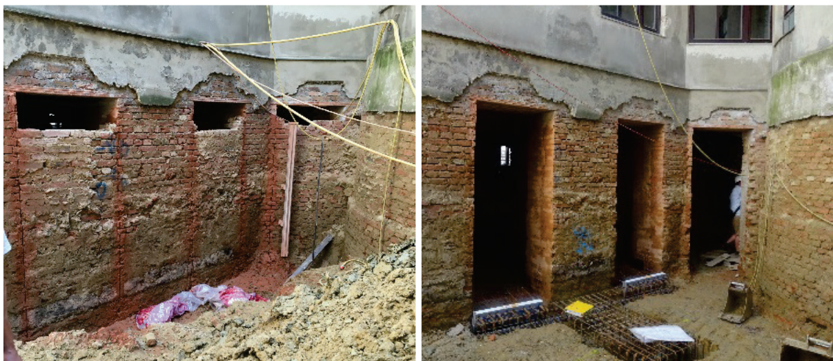
Abbildung 10: Absenkung des Hofniveaus und Öffnung der Kellerfenster bis zum Kellerboden am Beispiel Erlgasse 38; Fotos: Baustellendokumentation Gassner & Partner
