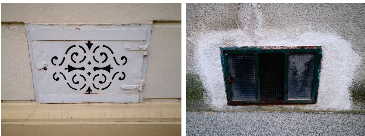
Abbildung 2: Fensteröffnung eines originalen, nicht sanierten Gründerzeitkellers (links); Fenstergitter mit Verschlussmöglichkeit (rechts)
