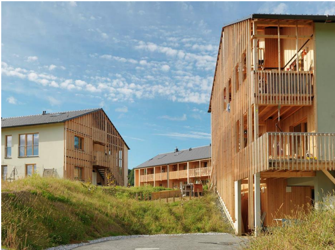
Abbildung 20: Ausblick auf die drei fertiggestellten Wohngebäude (Quelle: Ditz Fejer)
