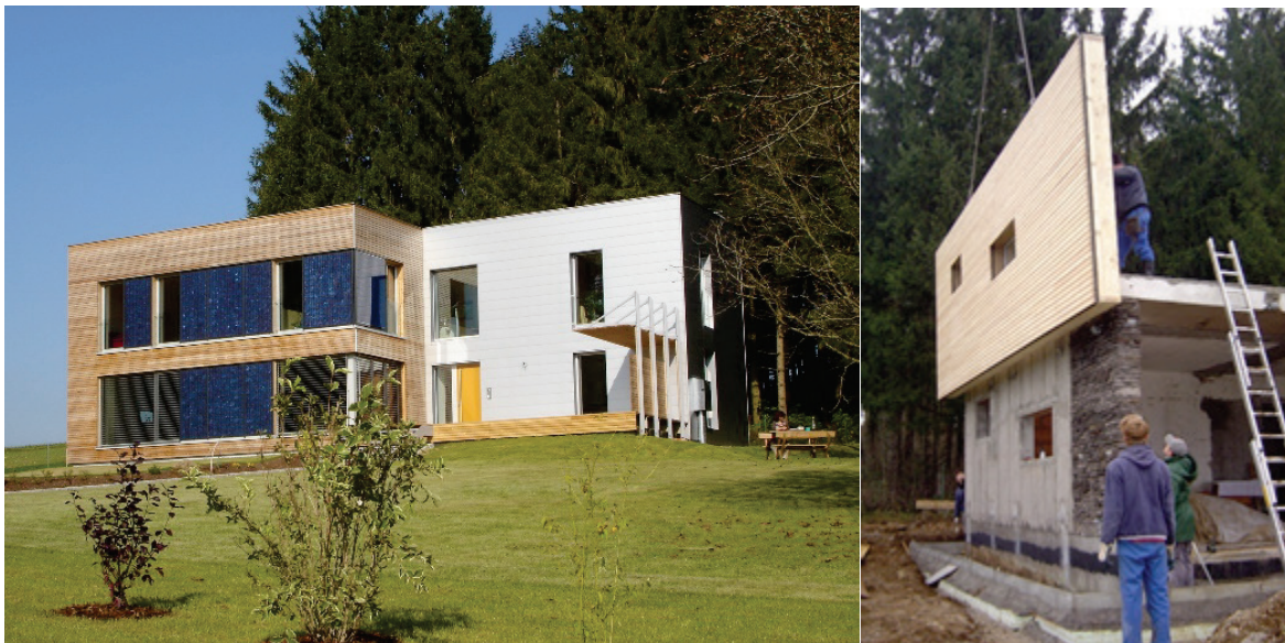
Abbildung 74: EFH Schwarz - Erste Sanierung zum Passivhaus in Österreich; Foto: LANG consulting
