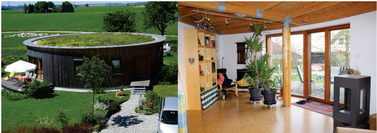
Abbildung 67: Einfamilienhaus in Roitham; Bauherrin/Bauherr: Christine und Günter Lang; Planung: HK Architekten Herman Kaufmann und Partner ZT GmbH; Foto: LANG consulting
