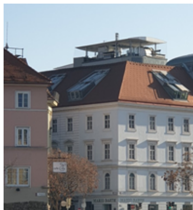
Abbildung 5: Bild einer Abwärmequelle am Dach
