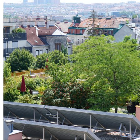
Kombination von Photovoltaik und Dachbegrünung
