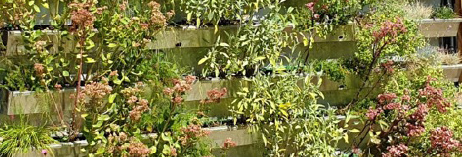
Fassadenbegrünung mit linearen Trögen
