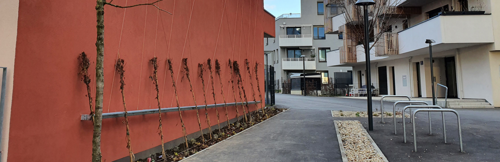
Eine bodengebundene Fassadenbegrüung in der Biotope City Wienerberg kurz nach der Pflanzung
