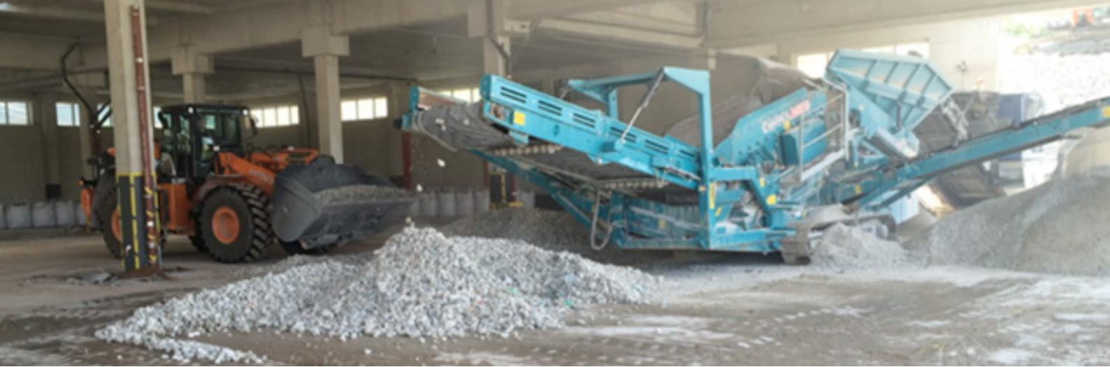
Brechen des Betons vor Ort
