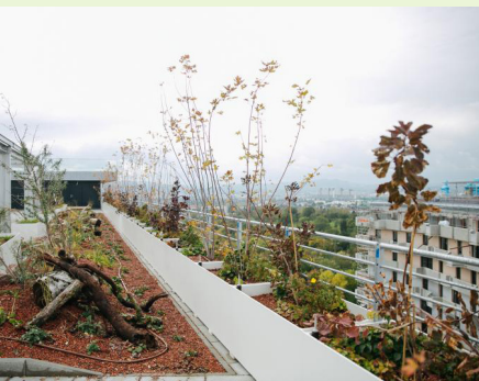
Kombination unterschiedlicher Elemente auf dem Dach am Beispiel des Bauplatz 5 der Biotope City Wienerberg (Wien-Süd)
