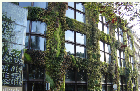
Das „Musée du Quai Branly“ in Paris mit einer 200 m langen und 12 m hohen Grünwand (Gilles Clément and Patrick Blanc)
