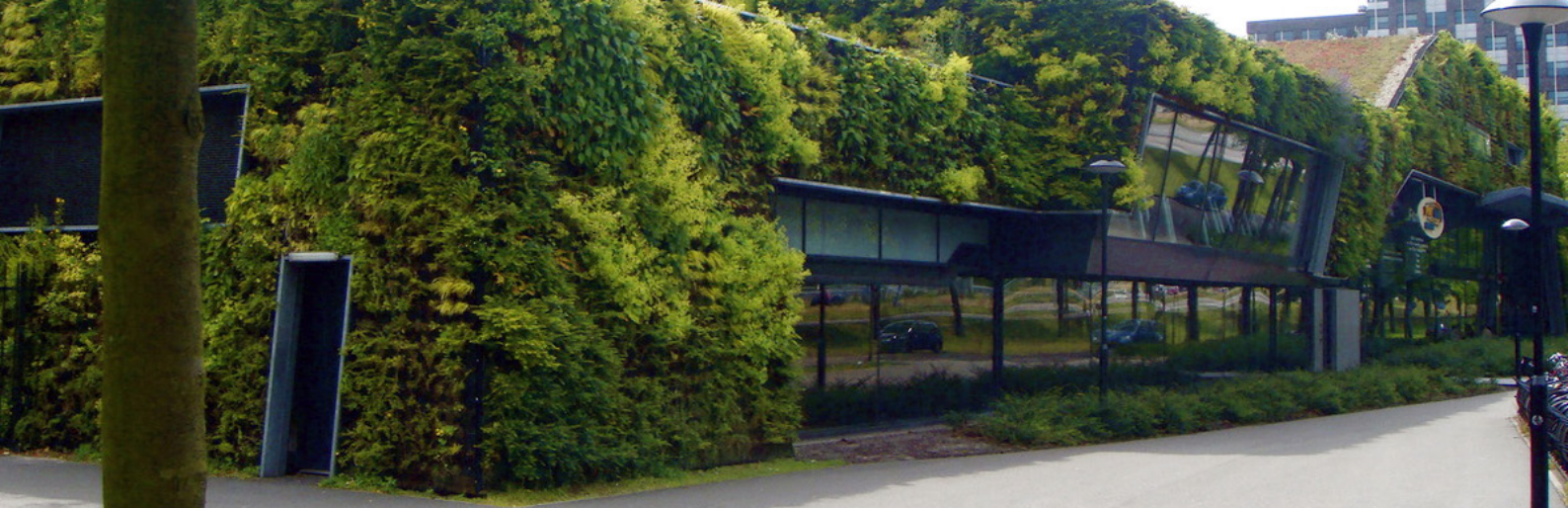
Fassaden- und Dachbegrünung am „Mercator Hallenbad“ in Amsterdam (Architektur: Ton Venhoeven, Bauherr: Sportfondsenbad Nederland, Gemeinde von Amsterdam)
