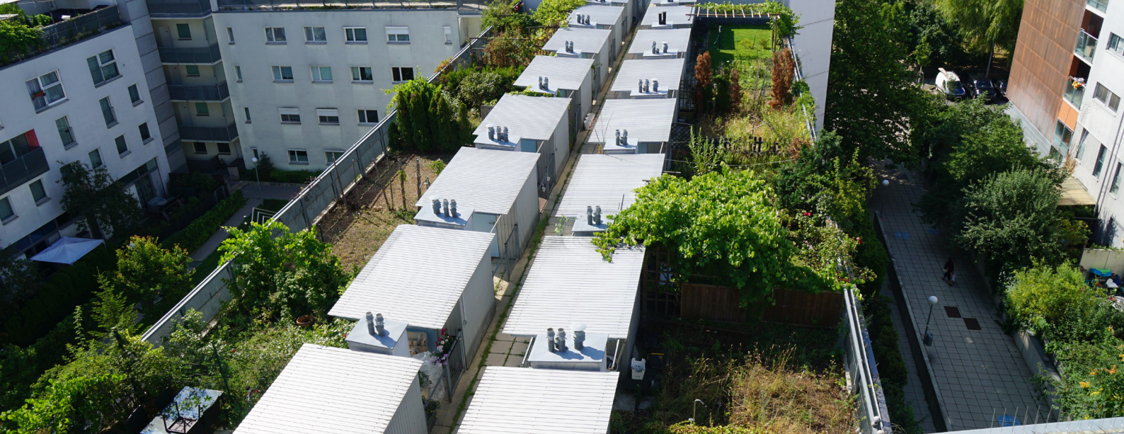
Dachdraufsicht mit intensiv genutzten Mieter*innengärten von a+k, Interethnisches Wohnen, Wien
