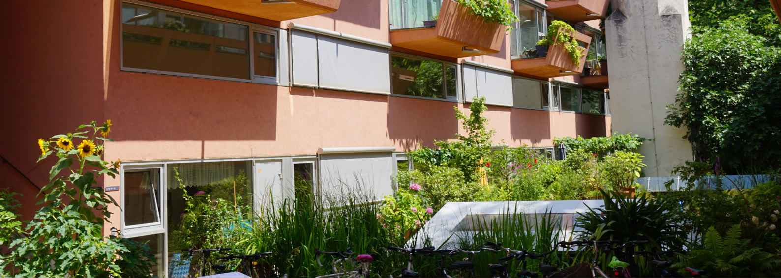
Die „Sargfabrik“ in Wien. Ein bereits 1996 eröffnetes Beispiel für eine umfassende Gebäudebegrünung
