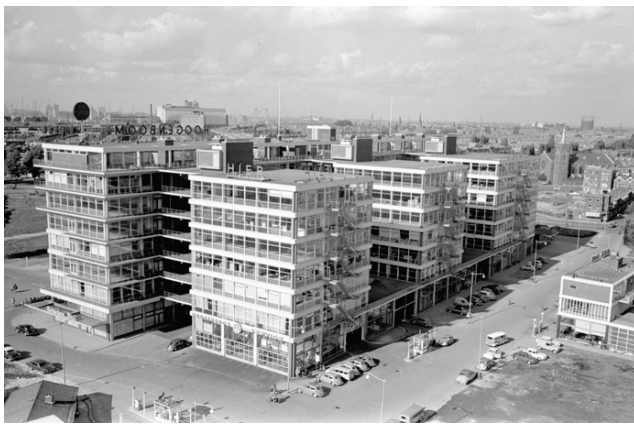
Abbildung 8: Gewerbehof Verzamelgebouw Rotterdam © Grootenhuijs Hans
