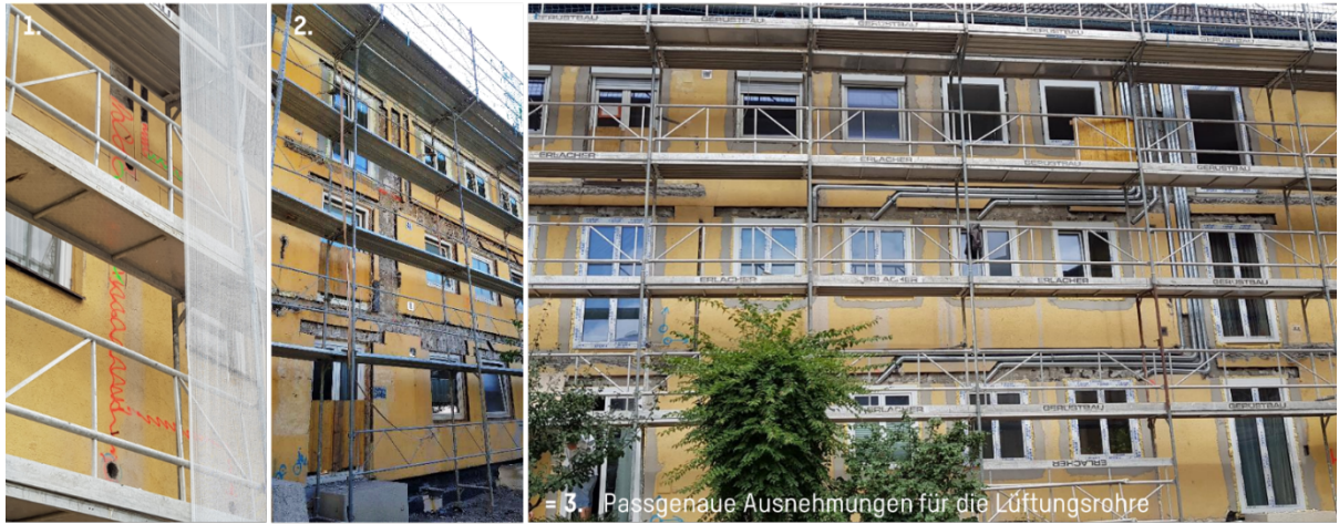
Abbildung 56: Die drei Schritte für optimale Leitungsführung an der Fassade: 1. Genaues Anzeichnen auf der Bestandsfassade, 2. exaktes Ausheben der bestehenden Dämmung & Putz, 3. Einpassen der Lüftungsleitungen ohne großen Zwischenraum; Quelle: NEUE HEIMAT TIROL
