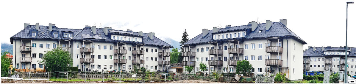
Abbildung 50: Die „Franzosenhäuser“ fertig saniert und fit für die Klimawende; Quelle: NEUE HEIMAT TIROL
