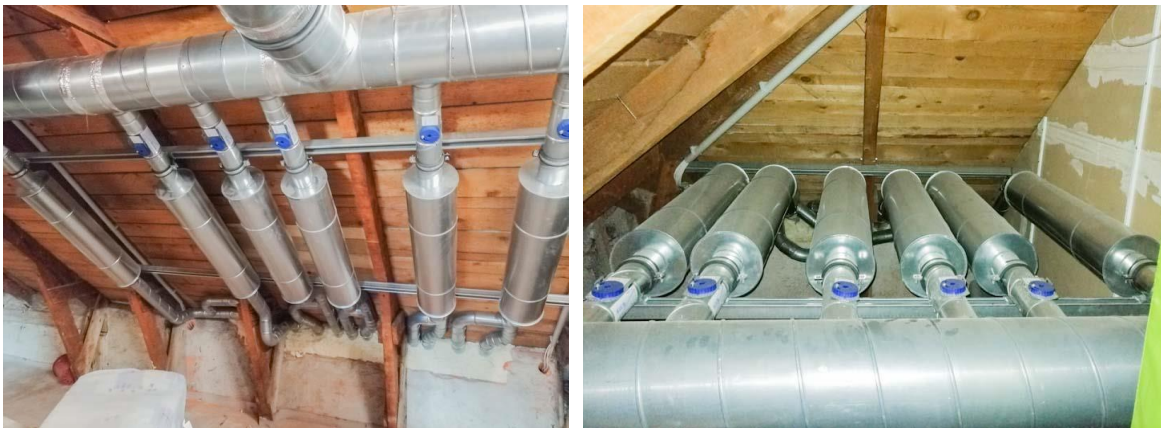
Abbildung 55: Luftverteilerbalken mit Volumenstrombegrenzer; Quelle: Alpsolar Klimadesign
