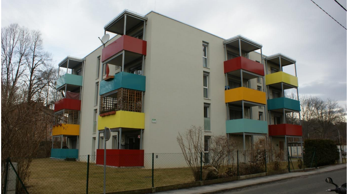
Abbildung 24: Südostansicht des Wohngebäudes Am Rehgrund 17 Graz; Quelle: AEE INTEC
