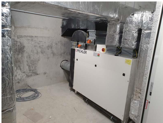
Abbildung 64: Lüftungsgeräte und Frischluftansaugung unter den neuen Balkonen; Quelle: Alpsolar Klimadesign
