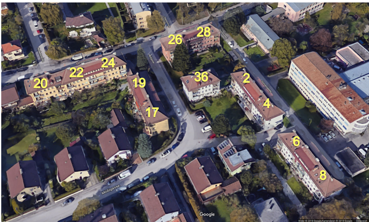
Abbildung 51: Gesamtansicht der unsanierten Objektgruppe; Quelle: Google Earth
