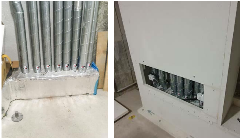
Abbildung 65: Luftverteilerbalken mit Volumenstrombegrenzer mit und ohne Brandschutzverbau; Quelle: Alpsolar Klimadesign
