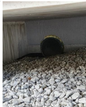
Abbildung 64: Lüftungsgeräte und Frischluftansaugung unter den neuen Balkonen; Quelle: Alpsolar Klimadesign
