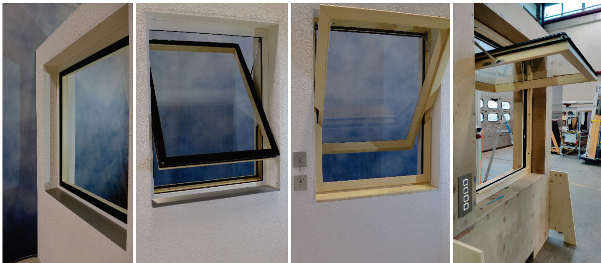
Abbildung 20: Prototyp C: Außenansicht geschlossen und halb geöffnet; Innenansicht halb und ganz geöffnet (eigene Fotos)
