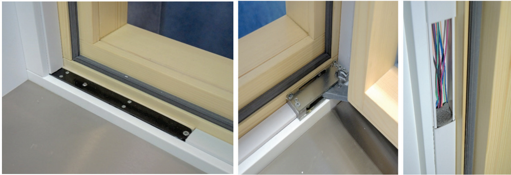
Abbildung 18: Prototyp B: Links, Verriegelungsmodul; Mitte, Eckmodul; Rechts, Kabelkanal (eigene Fotos des Projektkonsortiums FIVA)
