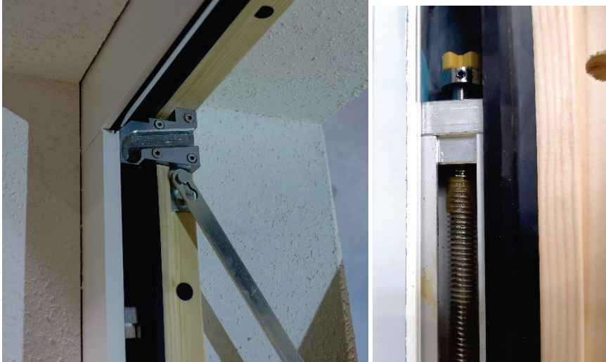
Abbildung 21: Prototyp C: Links, Einlaufkulissee und Schere; Rechts, Spindeltrieb (eigene Fotos)
