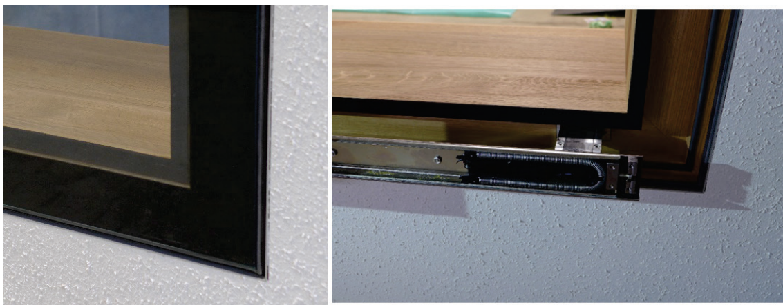
Abbildung 28: Links, außen flächenbündig; Rechts, Teleskopschiene mit Fangeinrichtung zum selbstständigen Schließen (eigene Abbildungen, Projektconsortium FIVA)
