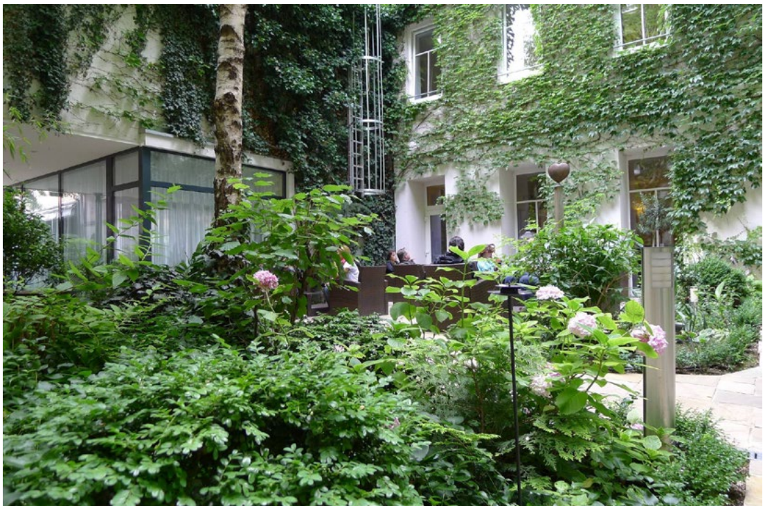
Abb.14: Begrünter Innenhof mit bodengebundener Fassadenbegrünung © GRÜNSTATTGRAU
