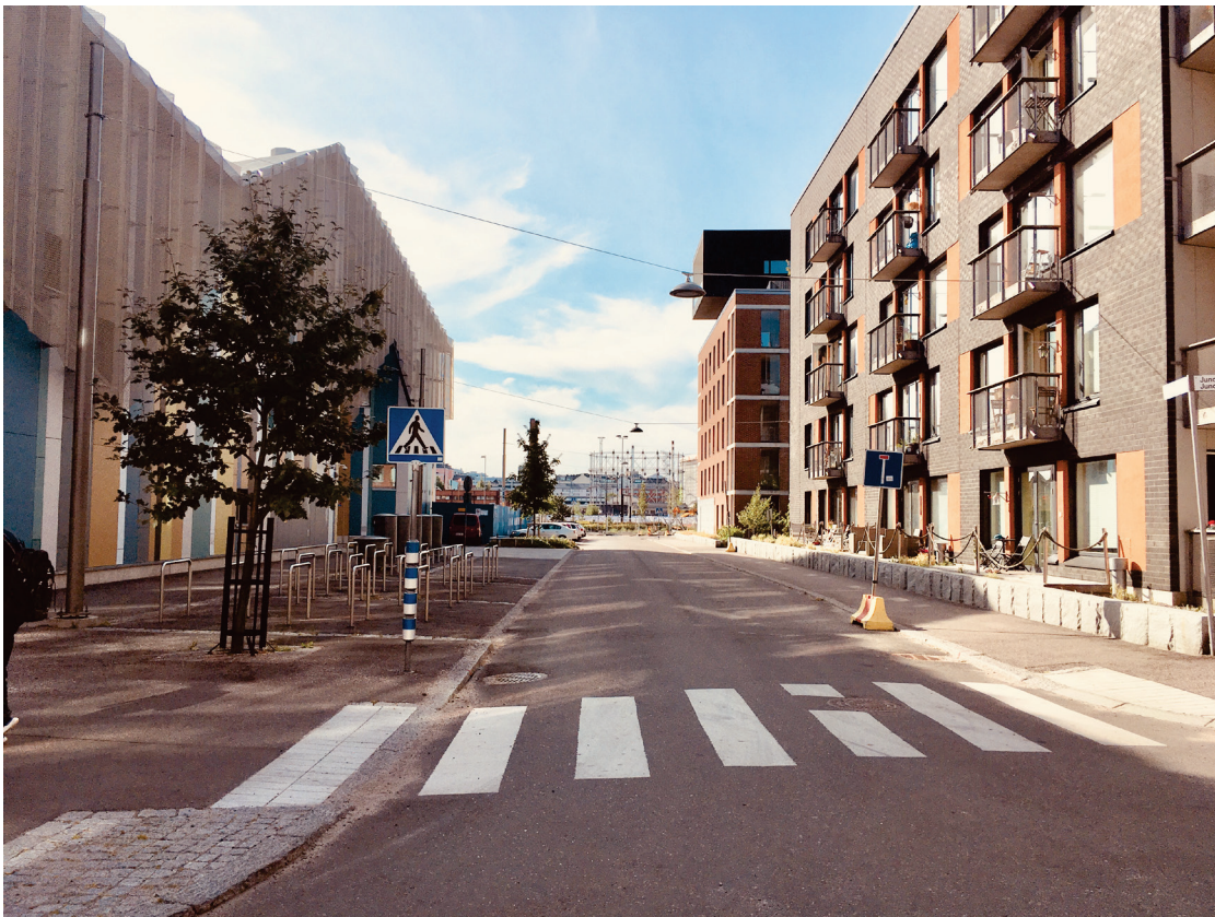
Abbildung 16 Kalasatama – hochwertige soziale Infrastruktur (Schule) Quelle: Radostina Radulova-Stahmer, Institut für Städtebau, TU Graz
