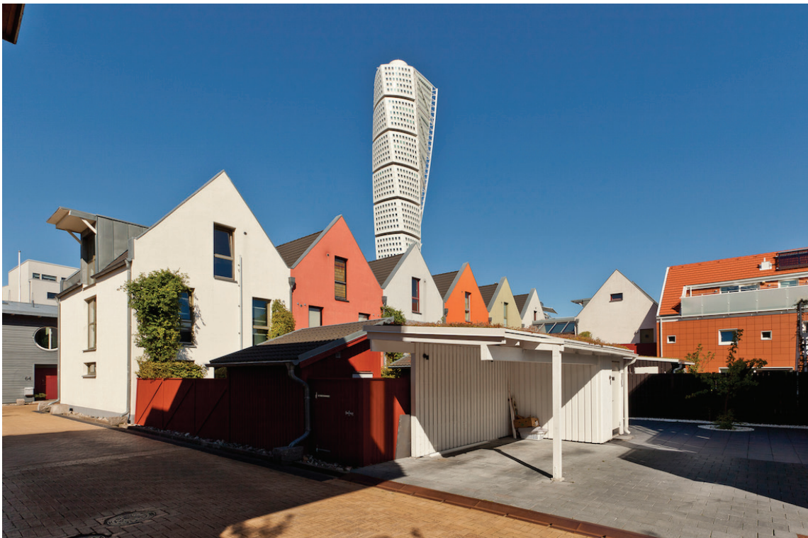
Abbildung 58 Västra Hamnen – Multifunktional nutzbarer Stellplatz Quelle: Martin Grabner, Institut für Städtebau, TU Graz
