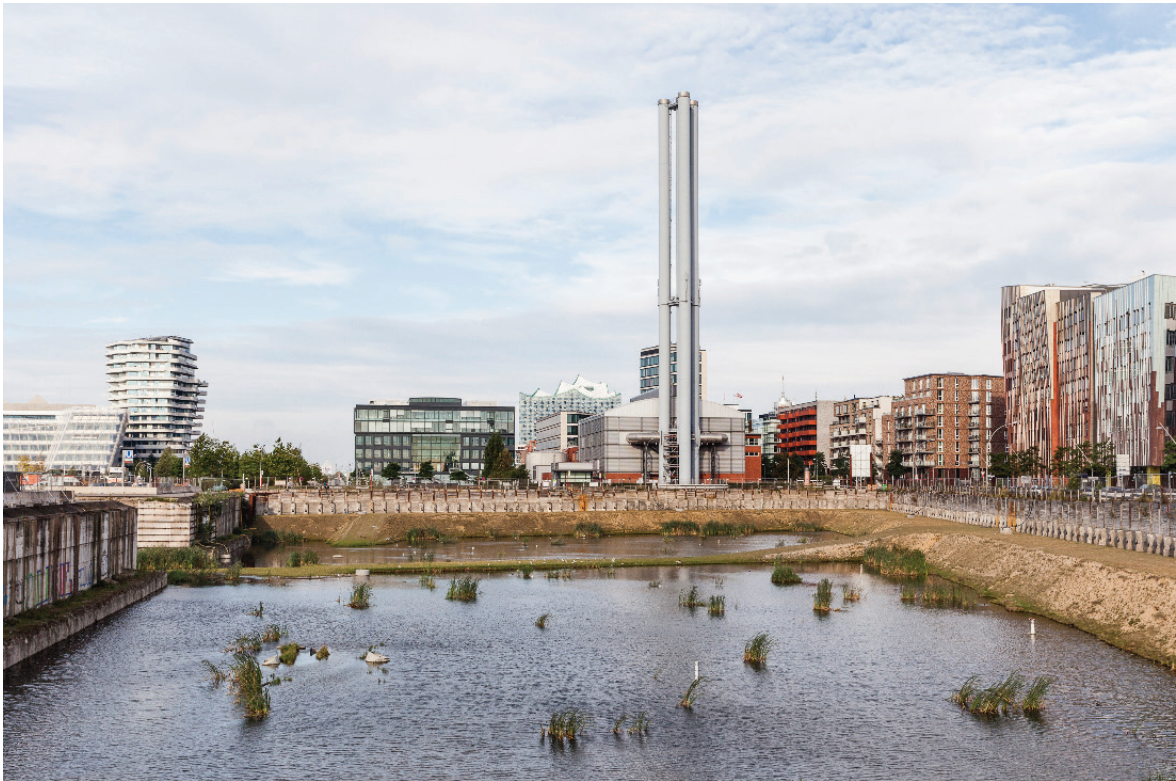
Abbildung 92 Hafencity - Retentionsfläche Quelle: Martin Grabner, Institut für Städtebau, TU Graz
