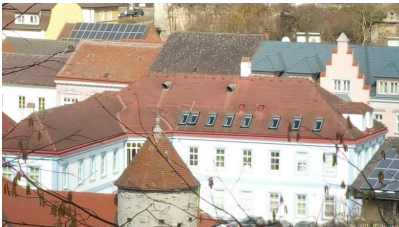
Abbildung 3: PV Dachfläche auf dem Gebäude Raika Thayatal-Mitte
