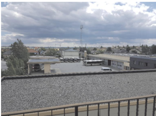
Abbildung 2: PV Dachfläche auf dem Gebäude FRANK-Reisen
