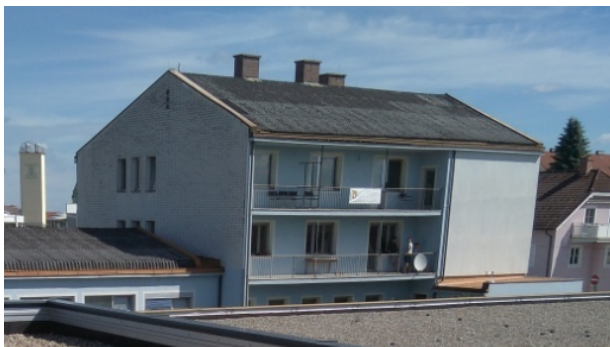
Abbildung 4: PV Dachfläche auf dem Gebäude Bauernladen Waidhofen
