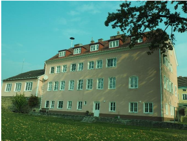
Abbildung 5: PV Dachfläche auf dem Amtsgebäude Waldkirchen
