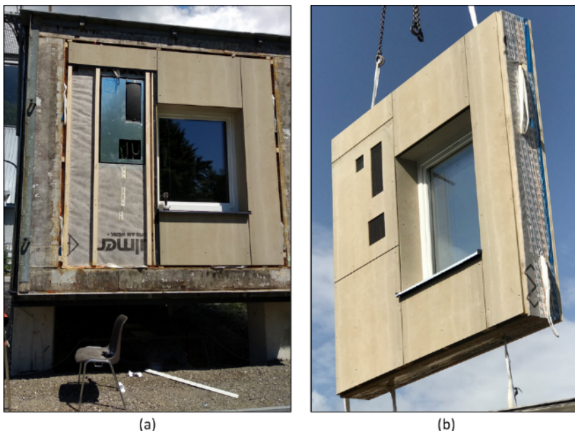
Abbildung 24: (a) Funktionsmuster einer vorgefertigten Holzfassade mit integrierter Außeneinheit der Heizungs-Lüftungswärmepumpe in der PASSYS Testzelle der UIBK und (b) während der Installation des Fassadenelements
