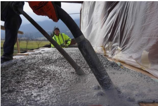
(c) Rütteln des Betons mit einer Rüttelflasche
