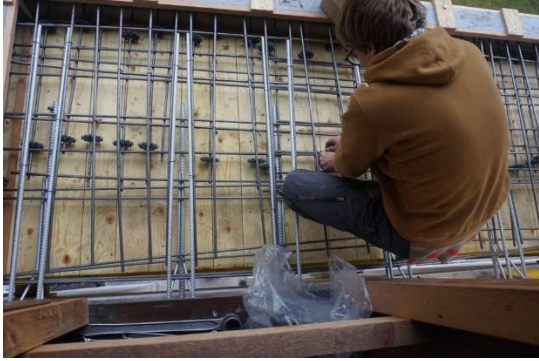
(a) Einflechten der Bewehrung des Balkons
