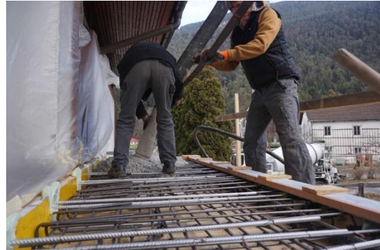
(b) Einbringen des Betons mit einer Fahrmischerbeton-pumpe
