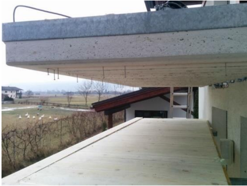
(a) Ablassen der Schalung mit einem Flaschenzug
