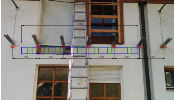
(a) Ansicht Fassade nach Abtrag des Bestandsbalkons - Vermerkung der sieben neuen Ankerpunkte
