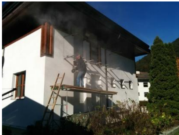
(a) Aufschneiden der thermischen Gebäudehülle
