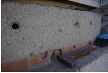
(a) Hilfsbohrung mit eingesetztem Spreizdübel
