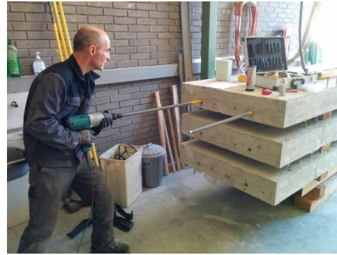
(b) Einbringen Betonschraube
