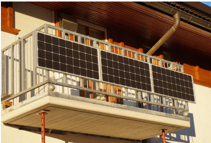
(c) Unterstützen des Balkons
