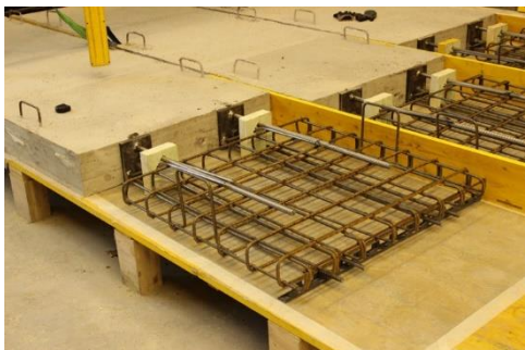
(e) Installation Abschalung Balkon
