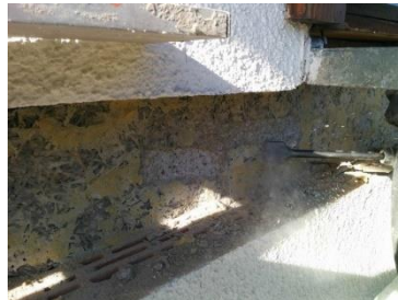
(b) Abspecken der Betonoberfläche
