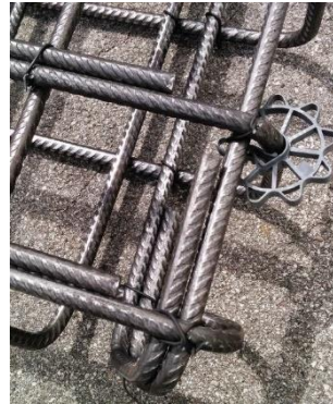
(b) Sicherstellung der Betondeckung mit Kunststoff-Stern-Abstandhaltern
