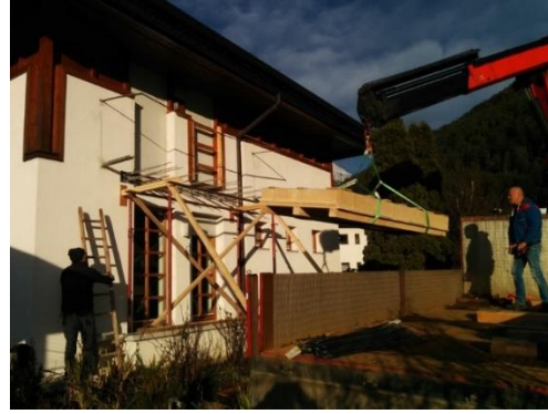
(b) Einheben der vorgefertigten Schalung mit einem Teleskopkran
