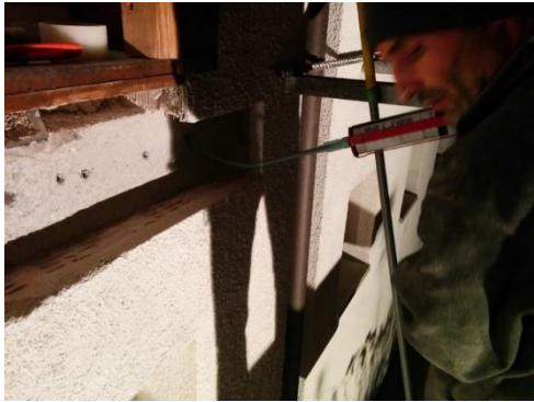
(b) Einbringung Verbundmörtels mit händischer Kartuschenpresse
