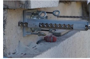
(c) Herstellung des Bohrlochs mit der Bohrführung
