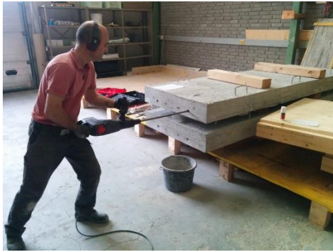
(a) Erstellung Bohrloch
