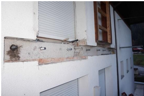
(d) Gesetzte Ankerpunkte abgelängt für die anschließende Montage des Entkopplungselements
