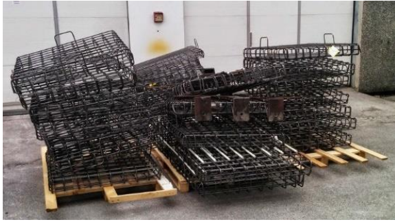
(a) Angelieferte Bewehrungskörbe
