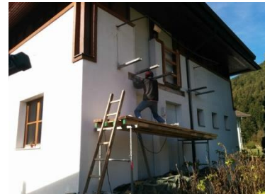
(c) Schleifen der Oberfläche
