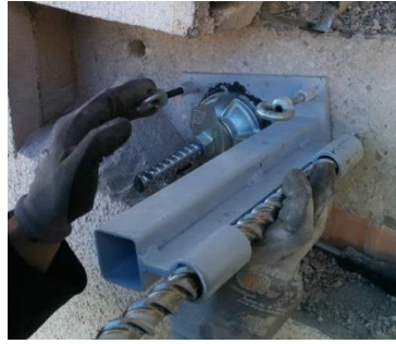
(b) Ausrichten der Bohrführung
