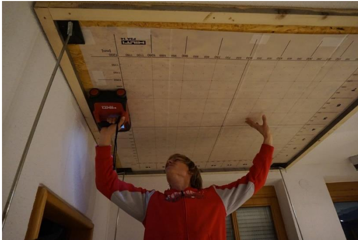
Abbildung 18: Messplattform und Rastermessung an der Deckenunterseite
