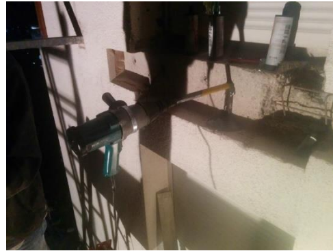
(c) Montage der Betonschraube – Eindrehen der mit einem Tangentialschlagschrauber
