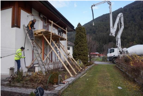
(a) Vorbereitung Betonage
