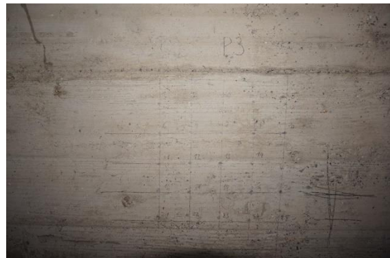
(b) Feld P3 an der Deckenunterseite
