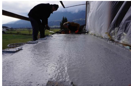
(d) Abzogener Beton
