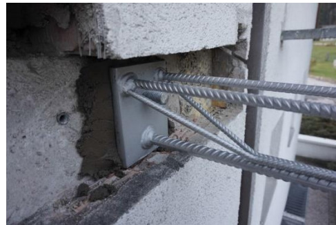
(e) Einbetten des thermischen Entkopplungselements „System II“ im Mörtelbett
