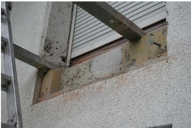
Abbildung 11: Punktuelle Freilegung Deckenstirnseite
