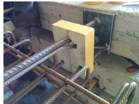
(d) Installation lokaler Dämmkörper zur Abschalung
