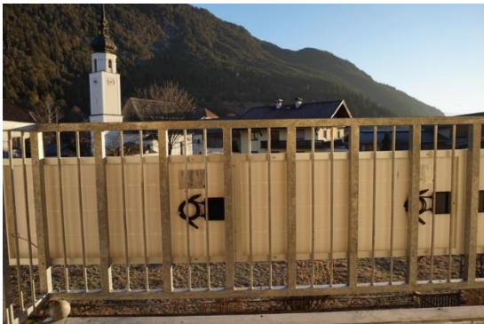
(d) Erste Aufnahmen vom THERM-opti-BALKON „System II“
