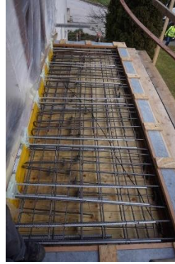
(b) Fertig eingebaute Bewehrung und Abschalung
