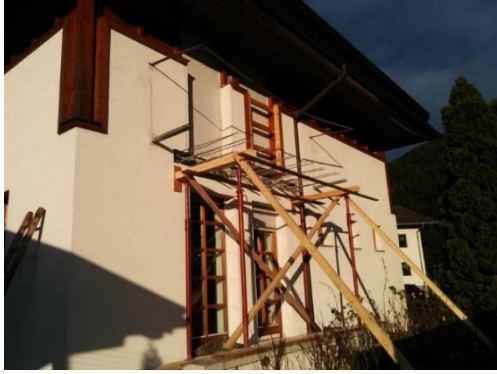
(a) tragfähige Plattform für die Schalung des Balkons
