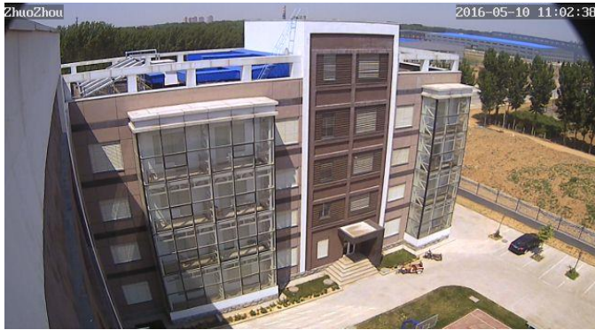
Abbildung 20: Foto von der Fassade bei Sonnenschein: alle Rollladen geschlossen.
