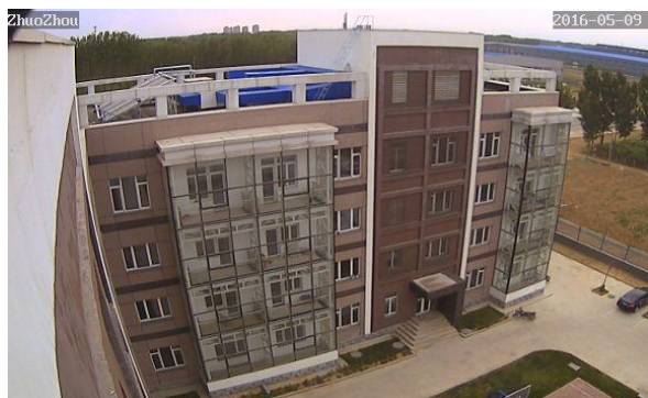
Abbildung 19: Foto von einer Fassade des Arbeiterwohnheims.
