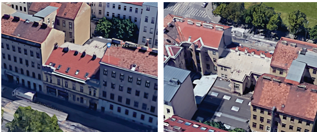
Abbildung 11: links: Beispiel im Projektgebiet „Innerfavoriten – Kretaviertel“ für die Darstellung der straßenseitigen und rechts: der innenhofseitigen Gebäudeansicht in Google-Maps 3D
