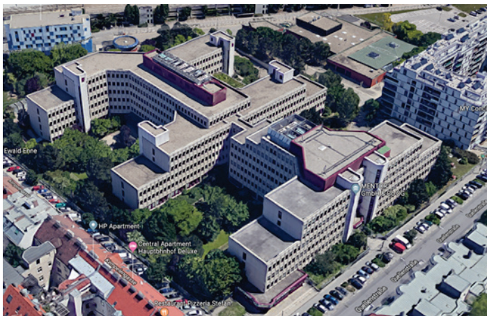
Abbildung 12: Ansicht des Gebäudes Quellenstraße 10/2c im Projektgebiet „Innerfavoriten – Kretaviertel“ in Google Maps 3D
