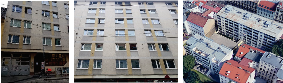
Abbildung 14: Beispiel „Neulerchenfelderstrasse 3/5/7“. Links: Fotoaufnahme der straßenseitigen Gebäudefassade, mit einem Ausschnitt der Erdgeschoßzone. Mitte: Fotoaufnahme der straßenseitigen Gebäudefassade, mit einem Ausschnitt der Obergeschoßzone. Rechts: Ansicht der innenhofseitigen Fassaden und Dachflächen in Google Maps 3D
