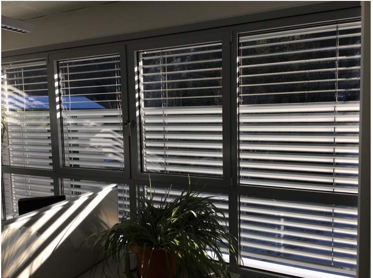
Abbildung 31: Beschattung Büro HELLA Gebäude
