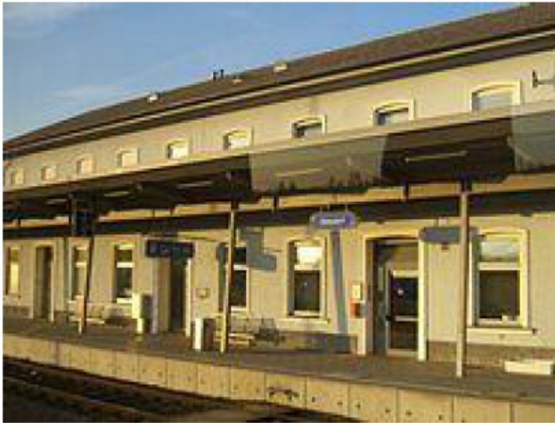
Abbildung 51: Bahnhofsgebäude Bahnhof Gleisdorf (vom Bahnsteig fotografiert)
