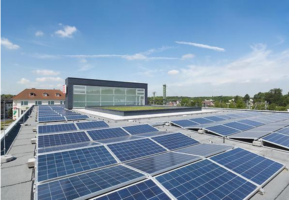
Abbildung 8: Photovoltaikanlage und Dachbegrünung auf dem Bahnhofsdach Horrem, DB Station&Service AG, Christian Gahl (Quelle: http://www.deutschebahn.com/de/bahnwelt/bauen_bahn/Bauen_an_Personenbahnhofen/Umwelt-Vorreiter_an_Bahnhofen/11875744/Gruener_Bahnhof.html#collapse11875720 ).
