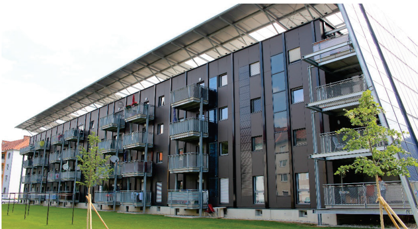
Abbildung 18: Sanierung Wohnhausanlage e80^3 (Quelle: AEE INTEC).
