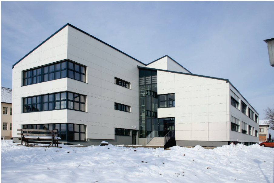
Abbildung 21: Sanierte NMS Rainbach (archevolution – Arch. Albert B. Böhm und Arch. Ingrid Domenig-Meisinger).
