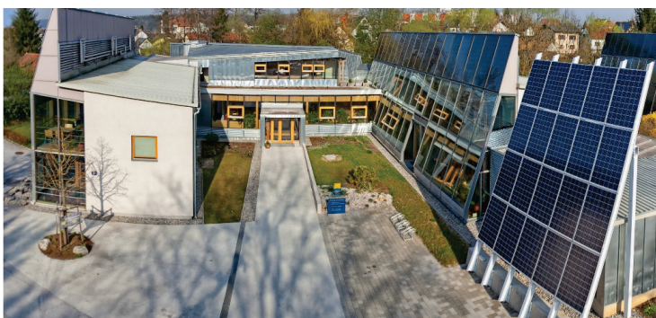
Abbildung 20: Bürogebäude AEE INTEC (Quelle: AEE INTEC / Gernot Muhr).
