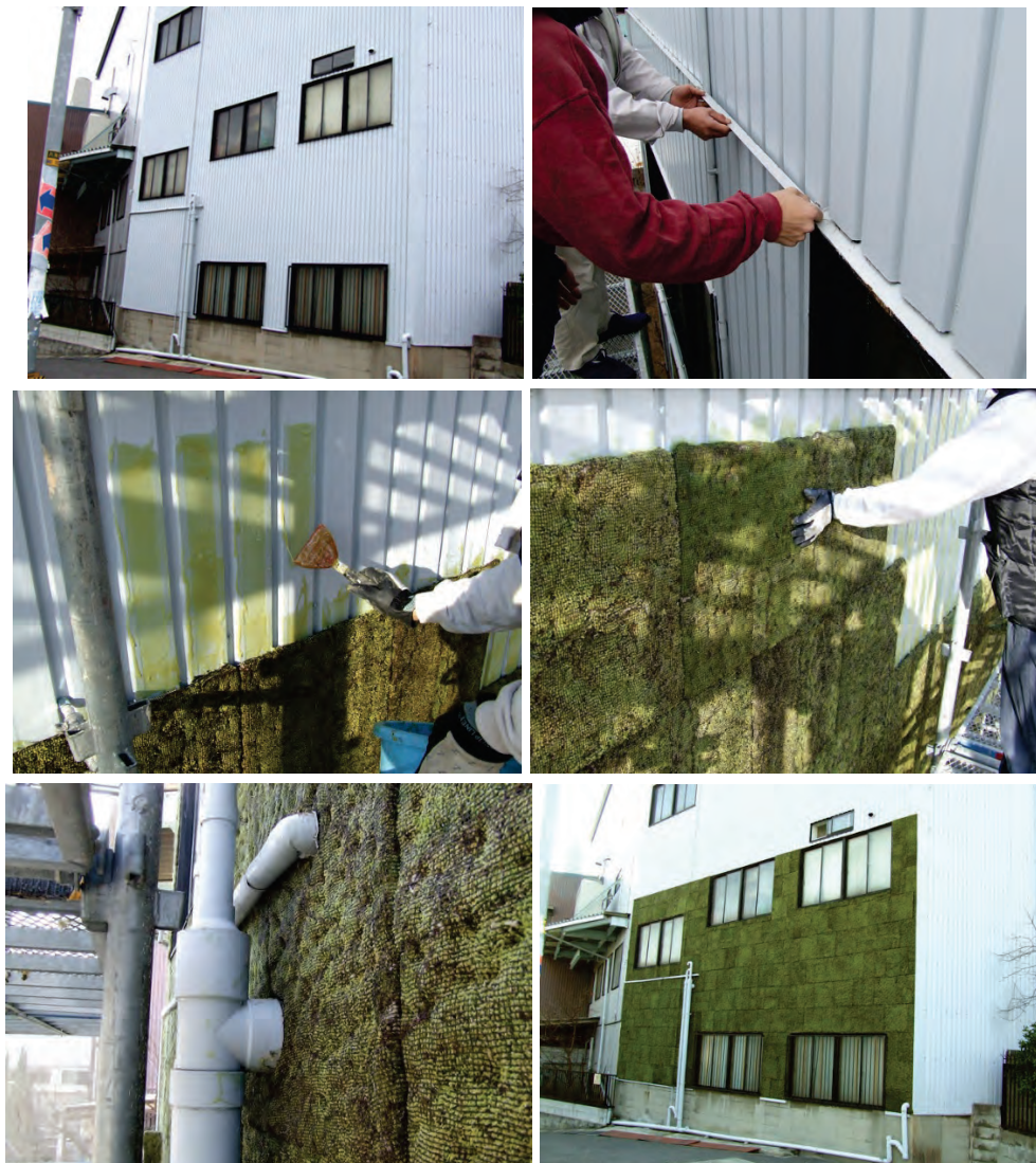
Abbildung 97 (l.o.), 98 (r.o.), 99 (l.m.), 100 (r.m.), 101 (l.u.), 102 (r.u.): Aufbringen der Moospanele auf einer Trapezblechfassade; Ursprüngliche Fassade (l.o.), Vorbereitungsarbeiten (r.o.), Aufstreichen des Klebers und Ankleben der Matten (l.m.), angeklebte Moosmatten (r.m.), Detailausbildung (l.u.) und fertige Fassade (r.u.) ; Bildquelle: Website Fa. Moss Mokokoko
