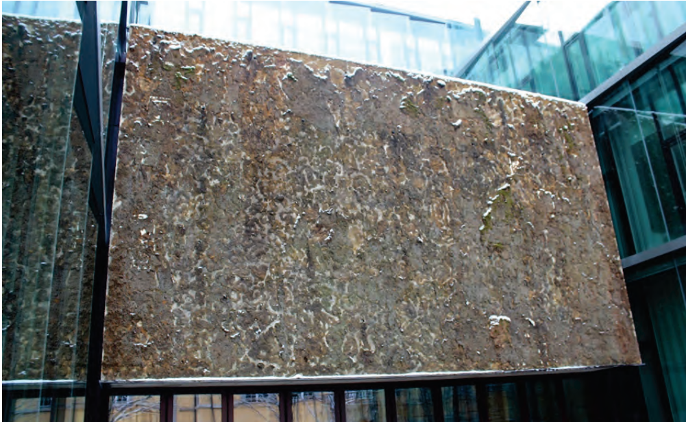
Abbildung 4: Bild der Fassade, Besichtigung Jänner 2015. Bildquelle: eigene Photographie (E. Heiduk)
