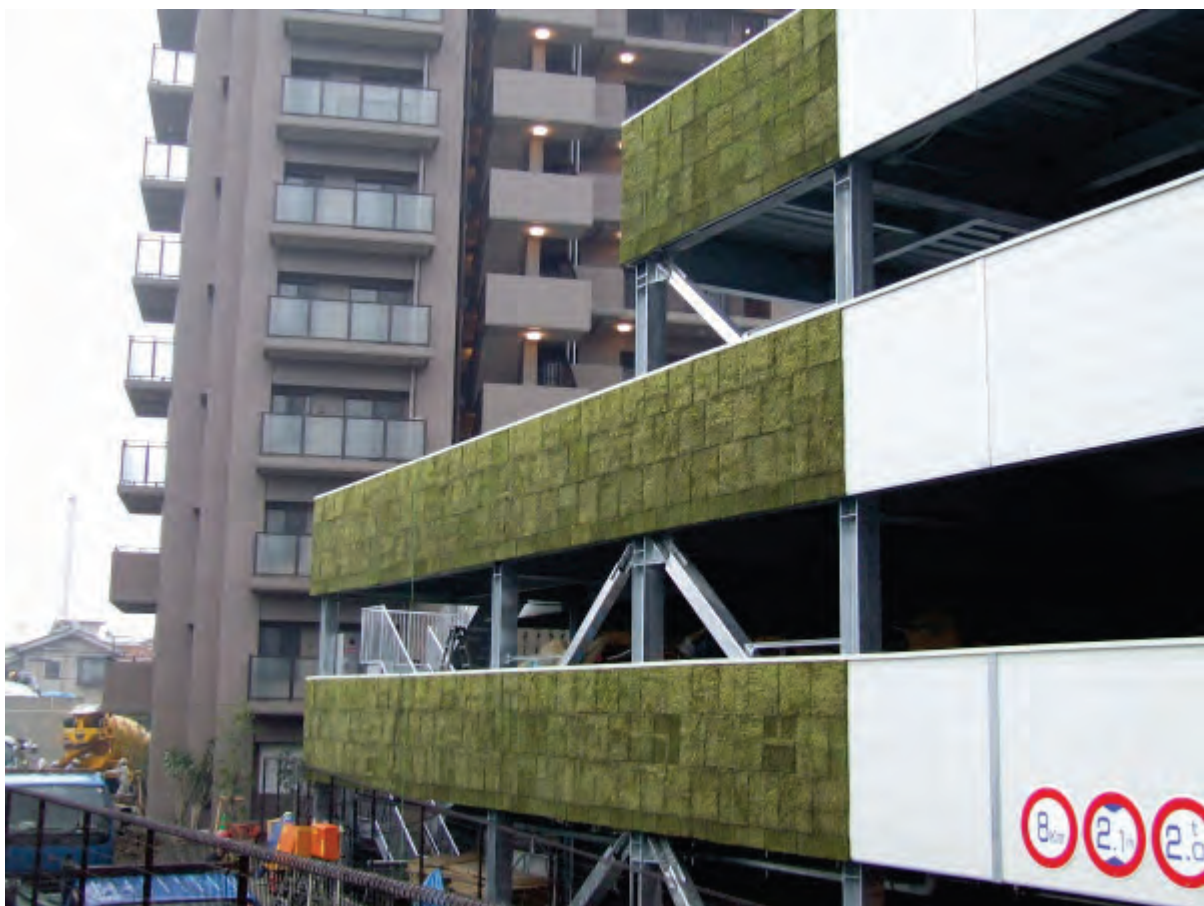
Abbildung 115 : Parkhaus in Adachi, Tokyo; fertiggestellte Mooswandstruktur; Bildquelle: eigene Photographie (E. Heiduk)
