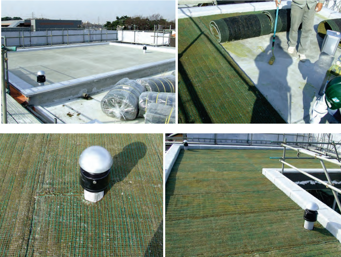
Abbildung 87 (l.o.), 88 (r.o.), 89 (l.u.), 90 (r.u.): Belegen eines vorhandenen Flachdachs (l.o.) mit Rollmoos (r.o.); Durchbruchdetail (l.u.) und fertiger Moosteppich (r.u.); Bildquelle: Website Fa. Moss Mokokoko
