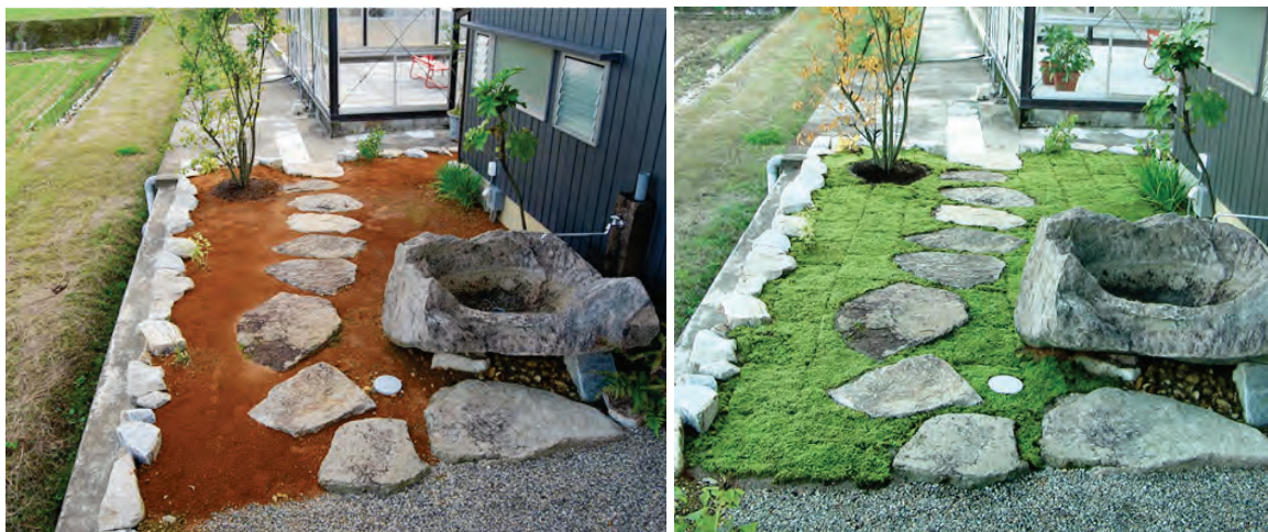
Abbildung 73(links) und 74 (rechts): Neuanlage eines kleinen Outdoor-Moosgartens mit Moosanzuchtboxen (Baustelle links, Fertiger Garten rechts); Bildquellen: www.cooljapanpress.com/topics/happymoss/en/
