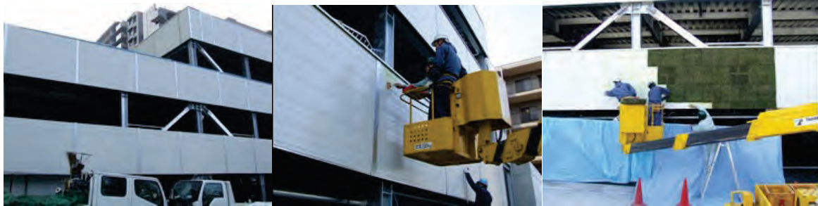
Abbildung 112 – 114 :Parkhaus in Adachi, Tokyo; Moosmattenmontage; Bildquelle: eigene Photographie (E. Heiduk)
