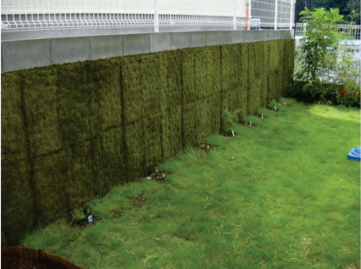
Abbildung 117 : Gartenmauer in Hachiouji City, Tokyo; Bildquelle: eigene Photographie (E. Heiduk)
