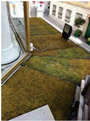
Abbildung 58 (links): Hotel Beethoven Wien, 30m 2 Außenmoos auf der Eingangsüberdachung Bildquelle: Firmenwebsite greenwalltec; Abbildung 59 (rechts): Fa. VTV Filmstudio – Auhofcenter Wien; Bildquelle: Firmenwebsite greenwalltec
