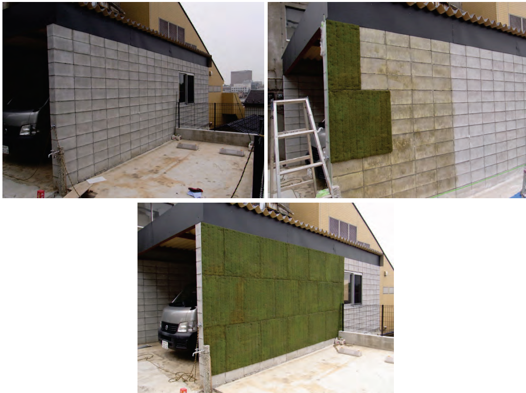
Abbildung 107 (l.o.), 108 (r.o.), 109 (unten) Aufbringung von Moosmatten auf einer Betonsteinwand: Betonsteinwand vor Baubeginn (l.o.), Wand mit Kleber und ersten aufgetragenen Moosmatten (r.o.), fertige Wand Stützmauer (unten) Bildquelle: Website Fa. Moss Mokomoko
