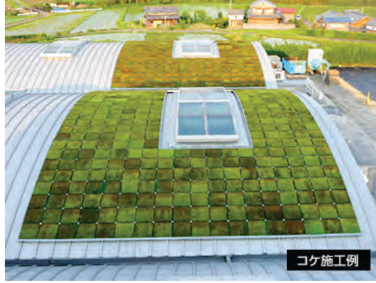
Abbildung 137 – 138 : Fertigungsprinzip der Moosmatten der Fa. Wakasa/ Kultivierungshallen (links), sowie Applikation auf einem Tonnendach (rechts); Bildquelle: www.urase.co.jp/ecology/
