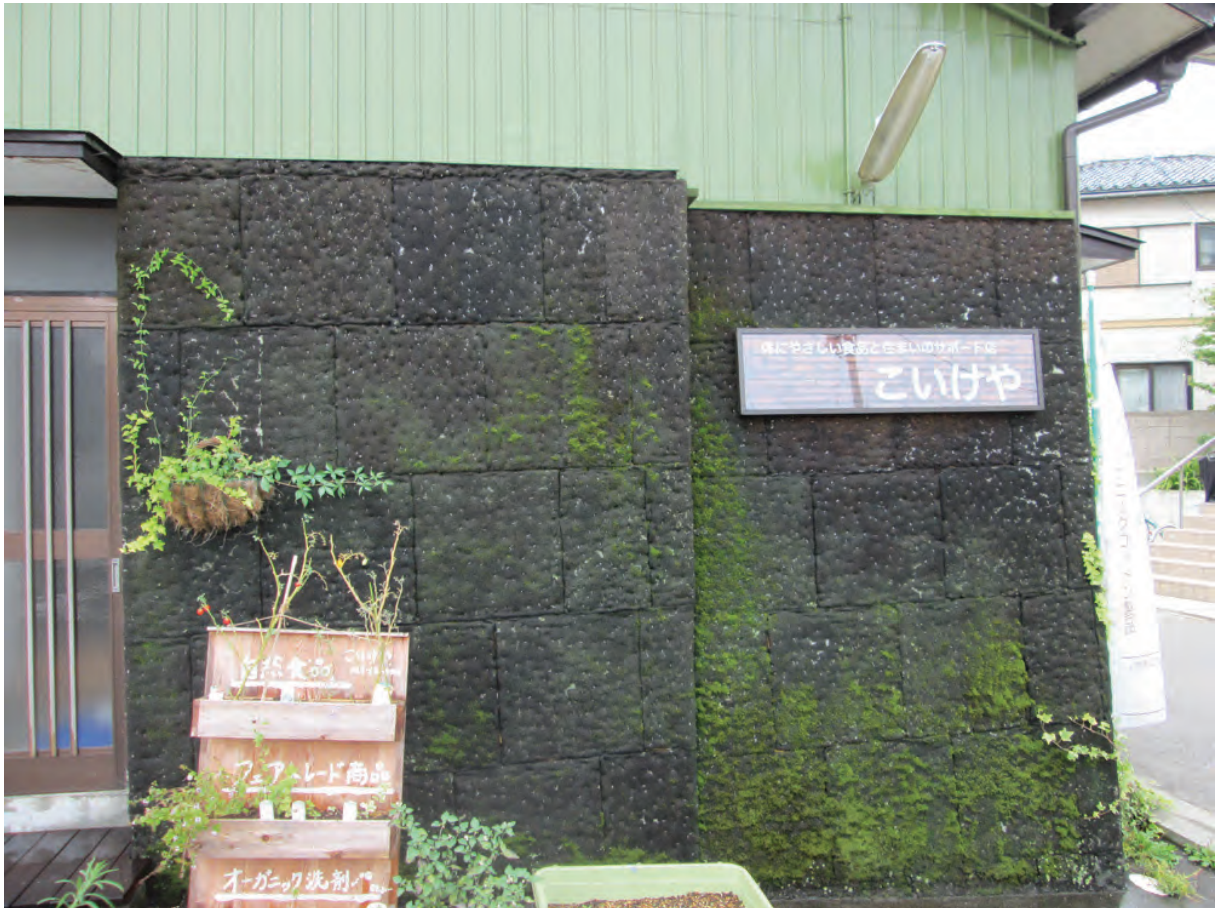
Abbildung 133 : montierte, nicht-vor-kultivierte Moosmatten an der Außenwand; Bildquelle: http://koike-inc.jp/1k188_koike/wp-content/uploads/IMG_0971.jpg
