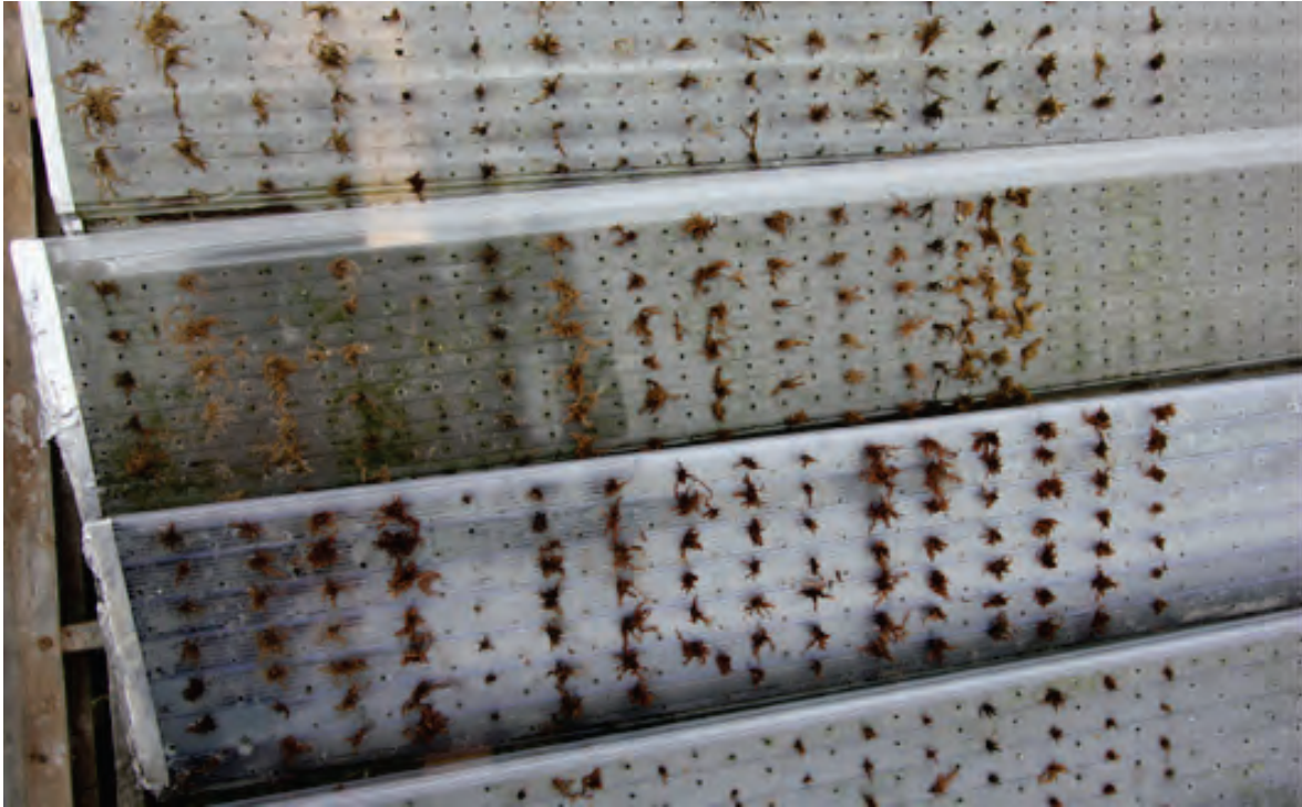
Abbildung 207: Abgestorbene Sprosse der Kunststoff-Doppelsteg-Platten (eigene Photographie - E. Heiduk)
