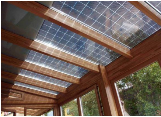
Abbildung 9: BIPV-Anwendungen - links Überkopfverglasung im Wintergarten, rechts integrierte Fassaden-Lösung und Absturzsicherung im Geländer (Quelle: Ertex Solar)
