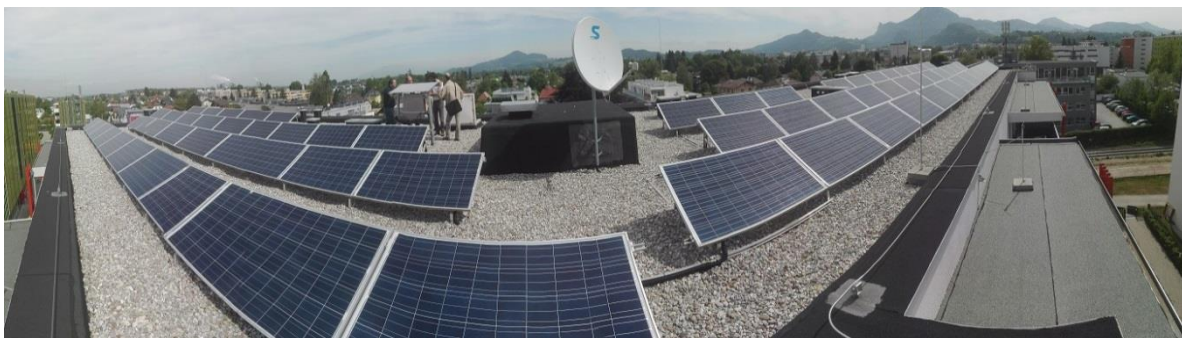
Abbildung 15: Musterhaus Salzburg mit 16,75 kWp, Jahresertrag 2016 in der Praxis: 1.071 kWh/ kWp
