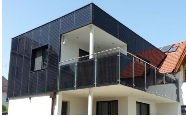
Abbildung 9: BIPV-Anwendungen - links Überkopfverglasung im Wintergarten, rechts integrierte Fassaden-Lösung und Absturzsicherung im Geländer (Quelle: Ertex Solar)
